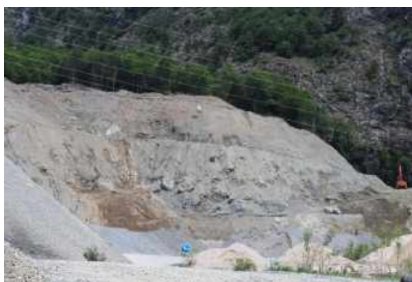
Figure 6 : Vue générale du front de taille de la carrière de la Vaudaine au Pont-de-la-Véna
