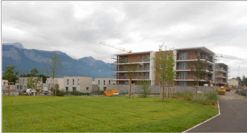
Illustration 41 : Photo chantier en cours (personnel)
