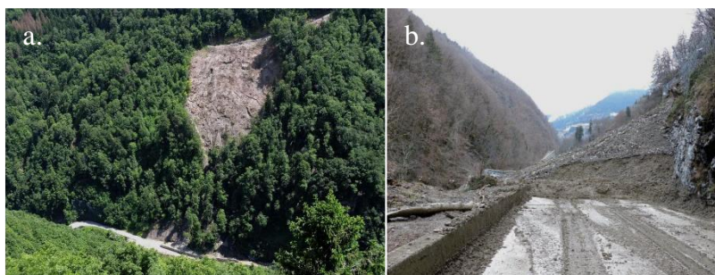
Photographie 1 : Mouvement de Montgombert : a. Vu de face du mouvement de Montgombert (Photo Brassoud, 2016) et b. Route départementale 1212 coupée (Photo Brassoud, 2018)
