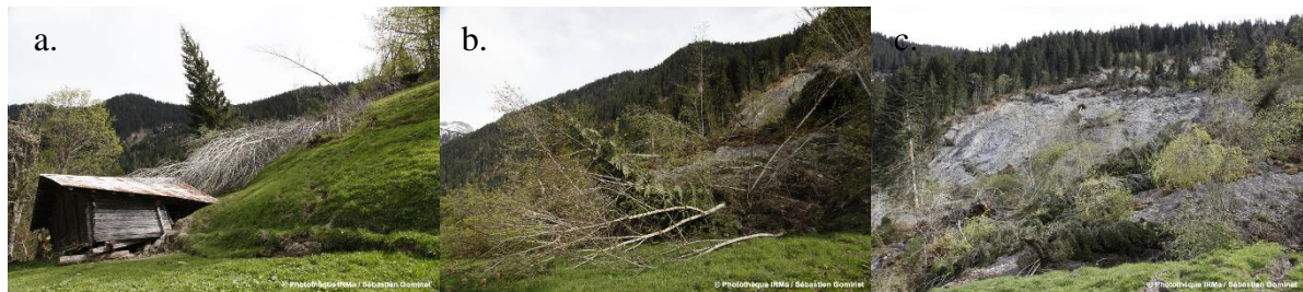
Photographie 2 : Glissement de terrain du Bersend : a. une grange poussée par la terre qui avance ; b. arbres basculés en rive gauche et c. niche d'arrachement (Photos Gominet, IRMa, 2016)
