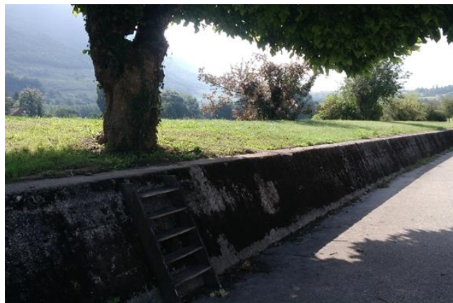
Digue de Massignieu (01)
