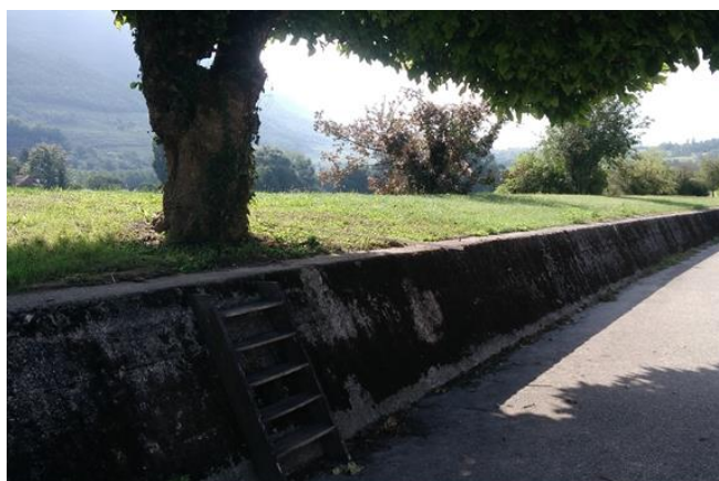
Digue de Massignieu (01)
