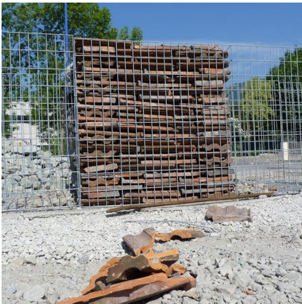
Figure 3: Remplissage de gabions avec des tuiles recyclées (NA Architecture, 2018)
