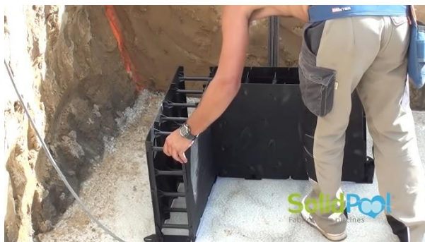
Figure 7: Mise en place et fixation des blocs SolidPOOL®, destinés à être recouverts d'un liner PVC, (SolidPOOL®, 2012)
