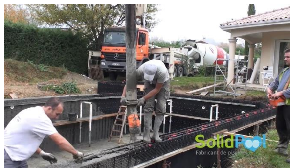
Figure 6: Coulage du béton dans les blocs SolidPOOL®, destinés à être recouverts de carrelage, (SolidPOOL®, 2012)
