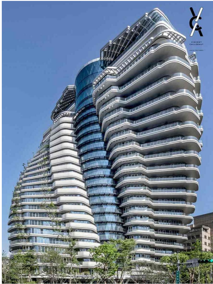
Figure 15 : Photo de la tour TAO ZHU YIN YUAN après sa construction
