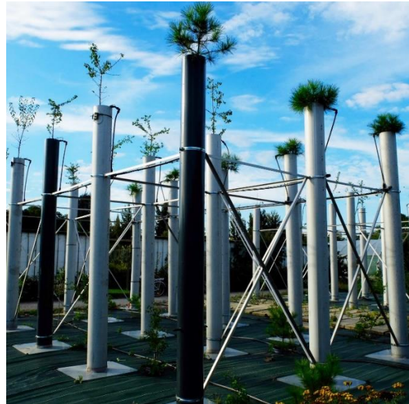
Figure 12 : Tubes inox plantés avant l'installation sur la façade de la Tour de la Biodiversité Source : Edouard François
