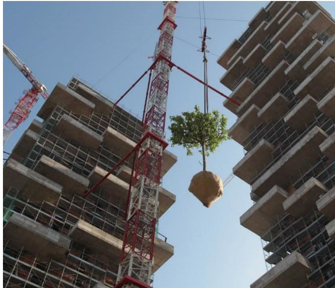
Figure 10 : Photo de l'installation d'un arbre sur le chantier de la Forêt verticale par Boeri à Milan Source : Marco Garofalo
