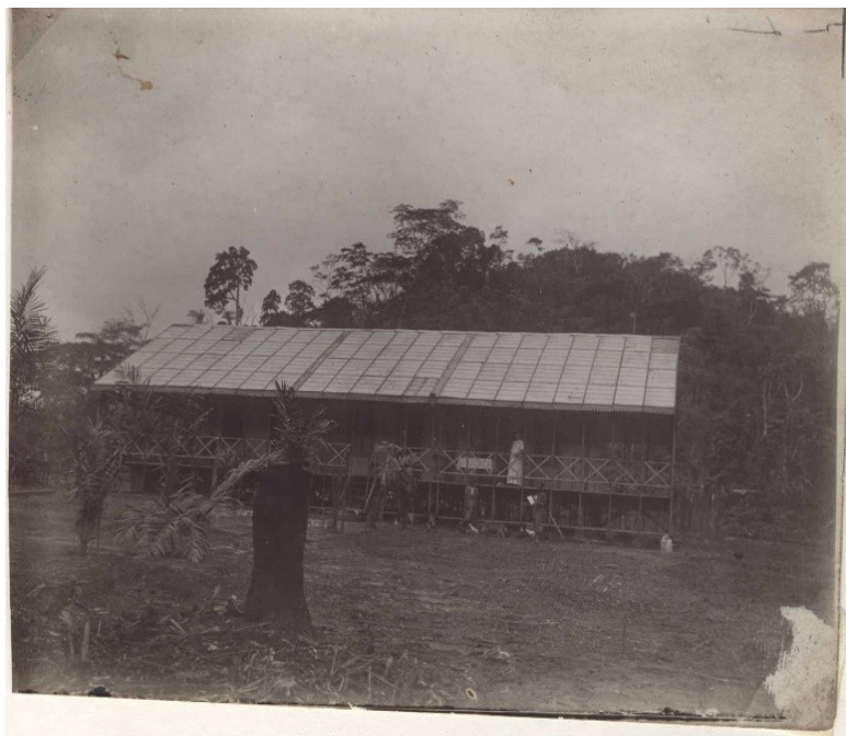
Illustration 12: « Maison démontable métallique, déplacée au fur et à mesure de l'avancement des travaux », 1910-1913
