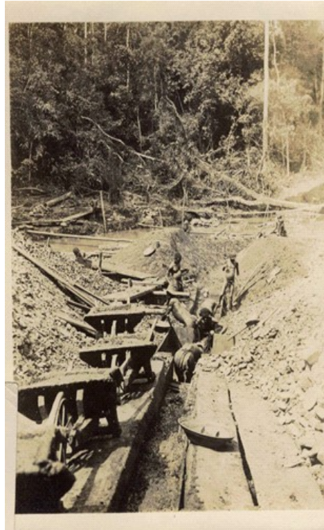
Illustration 16: « Clean up I, on ramène tout le gravier dans les bacs supérieurs »
