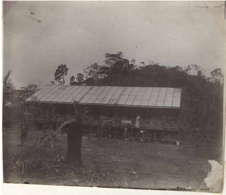
Illustration 12: « Maison démontable métallique, déplacée au fur et à mesure de l'avancement des travaux », 1910-1913
