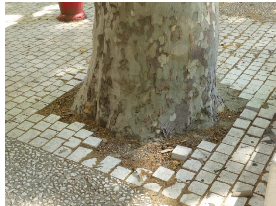
Figure 14 : Pavé non sellé au pied d'un platane rue Garibaldi à Lyon. (Photo : A. Meilleur)
