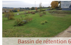
Bassin de rétention 6.
