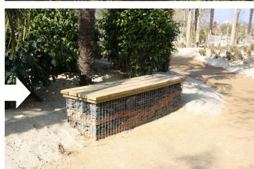
*De la pierre de Jérusalem du parvis additionnée avec de la brique et de l'enrobé pour réaliser sous la forme de gabion des assises.*
