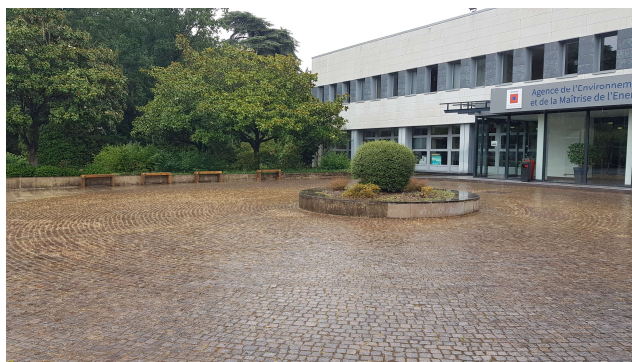
Figure 12 Le parvis d'entrée du site un espace ancien à retravailler, (Pethe, 2019)
