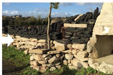
*De l'enrobé de voirie à une construction de muret associé avec des blocs de béton.*
