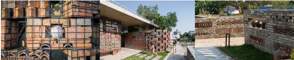
Figure 26 Les toilettes publiques de Zuzhai, (Atelier cnS, 2019)
