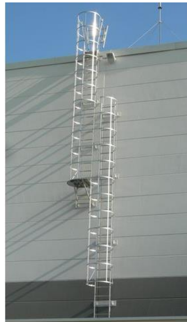
Figure 5 Echelle à crinoline, L'usine nouvelle, 2020
