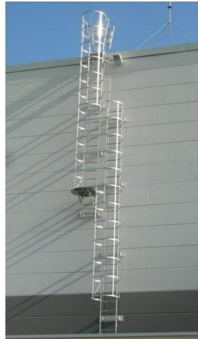
Figure 5 Echelle à crinoline, L'usine nouvelle, 2020
