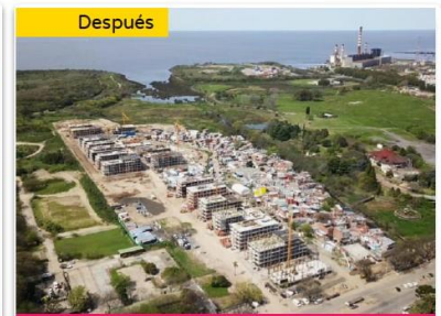
Avance de obra
