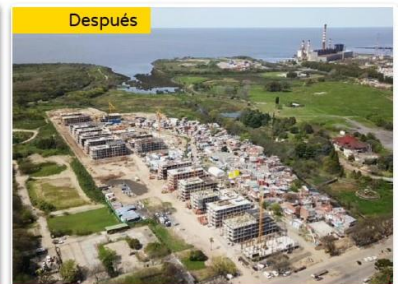
Avance de obra
