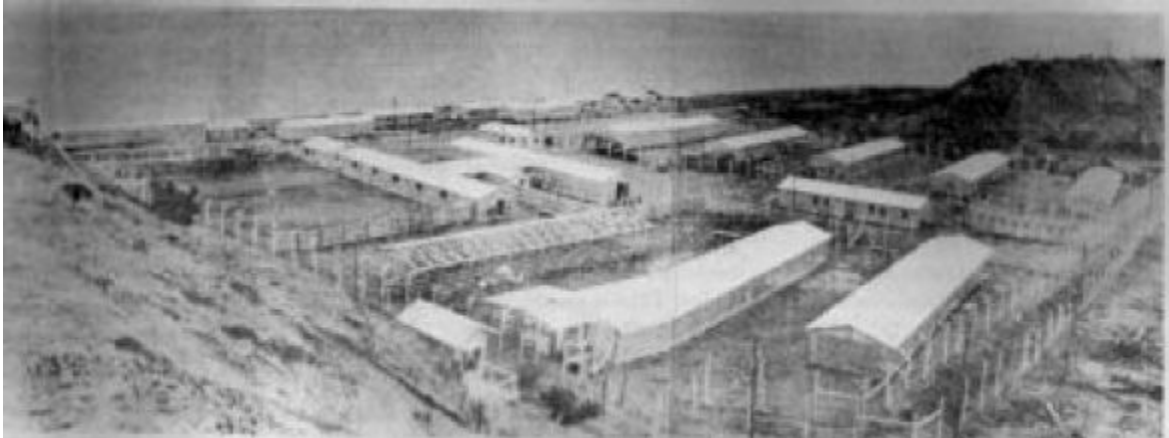
Vue d'ensemble du complexe concentrationnaire de la combe de Río Chico, et du camp presque entièrement construit.
