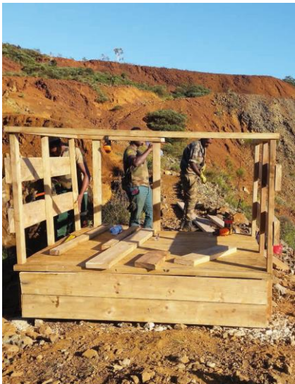
Figure 10 : chantier pour la création d'un point de vue à l'ancienne mine de Tiébaghi par la section MDT, site historique du Nord de la Nouvelle Calédonie – RSMA-NC
