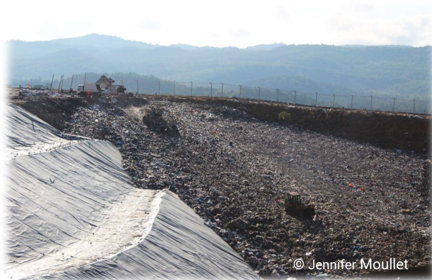
FIGURE 17 : CENTRE D'ENFOUISSEMENT DU BEYNON
