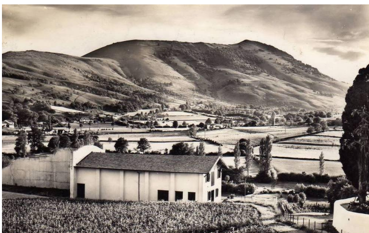
Figure 4 Photographie ancienne du village d'Helette : les landes occupent les monts (Source : Pays Basque 1900)
