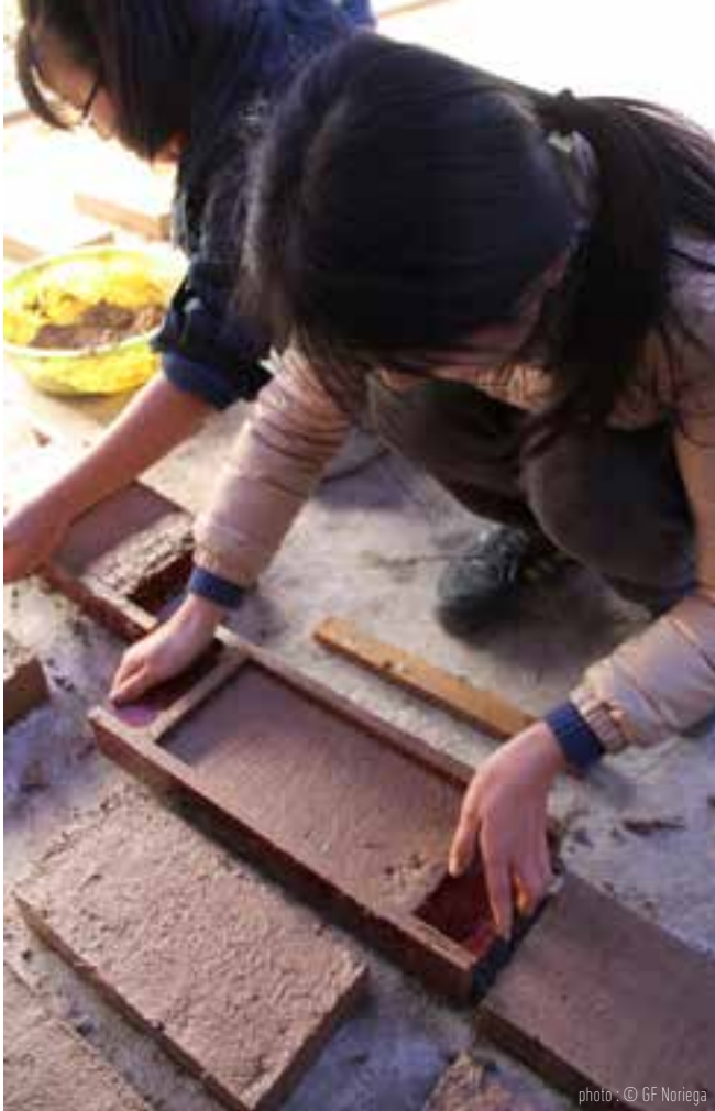
Moulage, séchage et stockage des adobes
