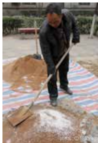
Mélange avec du sel pour éviter le gel
