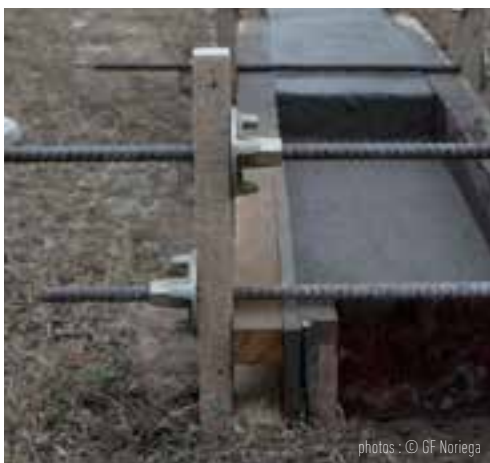
Réalisation du subassement en ciment damé
