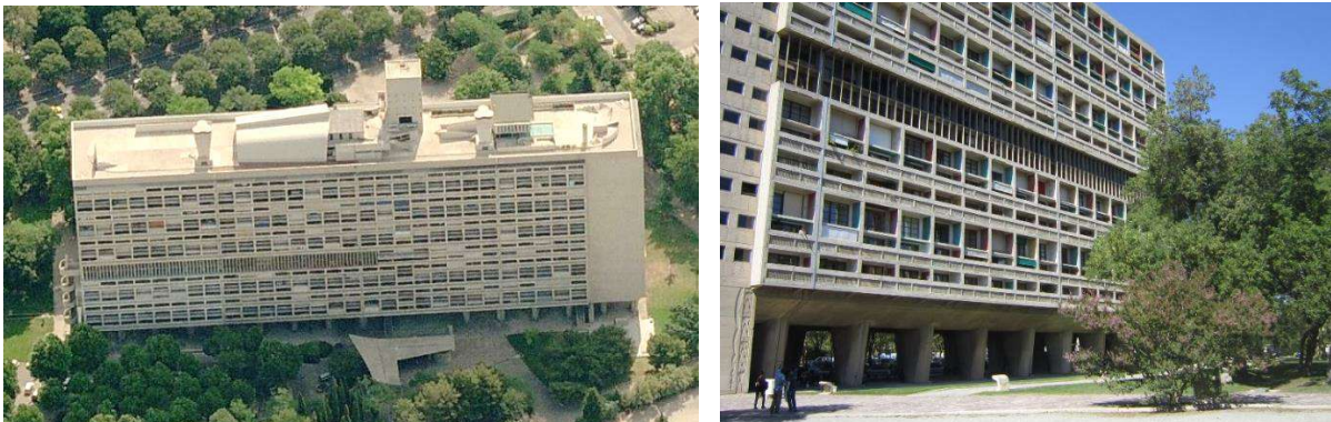
Figure 6 – La Cité Radieuse vue du ciel et de profil, Le Corbusier, 1952 https://cutt.ly/1fHdc4H
