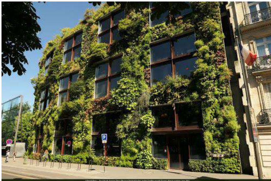
Annexe IV : Mur végétal de la façade du Musée du quai Branly à Paris, Patrick Blanc Photographie, 2017 https://cutt.ly/CfJqYWG
