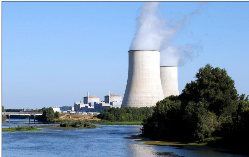
Figure 10 - Les deux réacteurs nucléaires de la centrale de Golfech à 100 km de Toulouse. Reuters/Regis Duvignau
