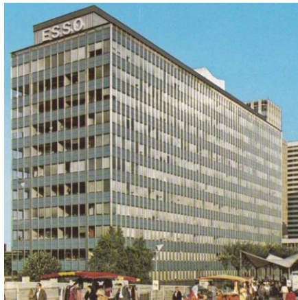
Figure 13 : La Tour Esso, la 1 ère tour de la Défense, construite en 1963 et détruite en 1993 (Source www.delcampe.net )
