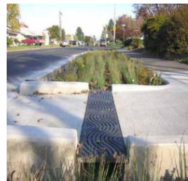
Figure 28: Exemple d'aménagement de bio-rétention (Garant, 2009)
