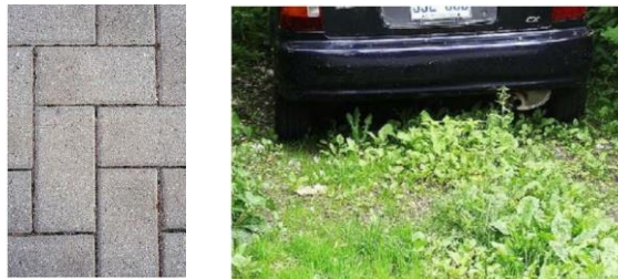
Figure 25: Exemple de revêtement perméable utilisé à Montréal (Giguère 2009).
