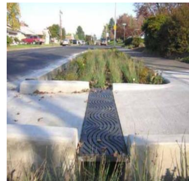
Figure 28: Exemple d'aménagement de bio-rétention (Garant, 2009)
