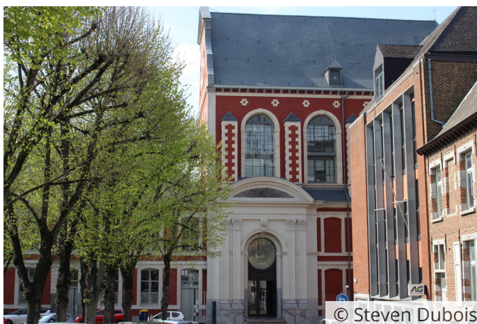
La façade et les toitures restaurées
