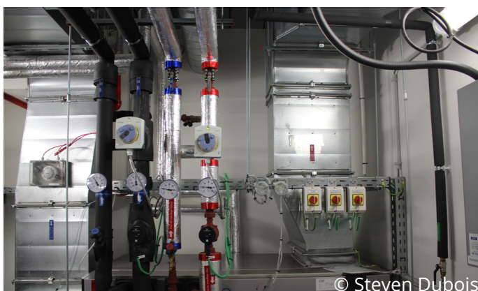
© Steven Dubois Le système de régularisation de la température et de l'hygrométrie
