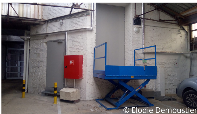
La quai de chargement et déchargement de l'Artothèque
