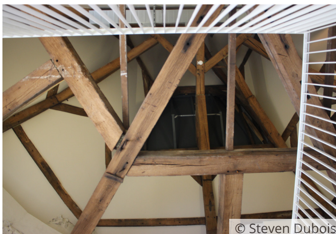
La charpente et ses poutres en bois
