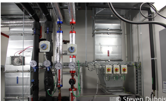
Le système de régularisation de la température et de l'hygrométrie
