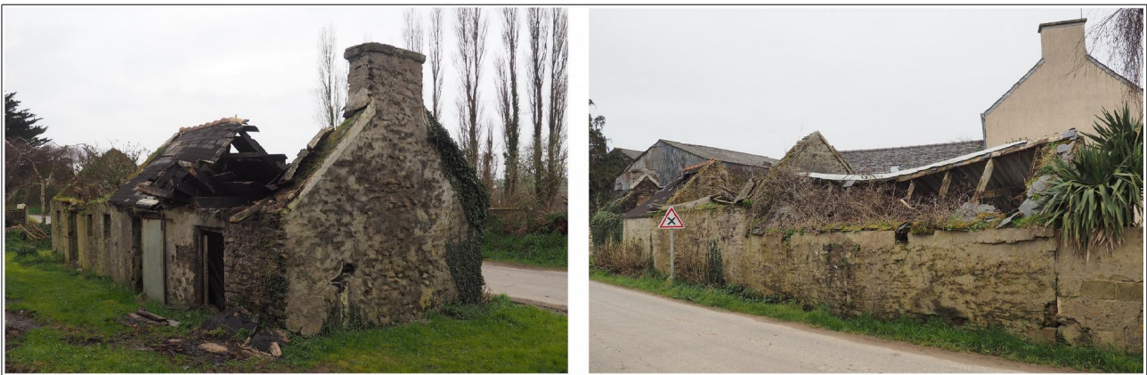
Ensemble des crèches et écuries actuellement à Kerlédéc
