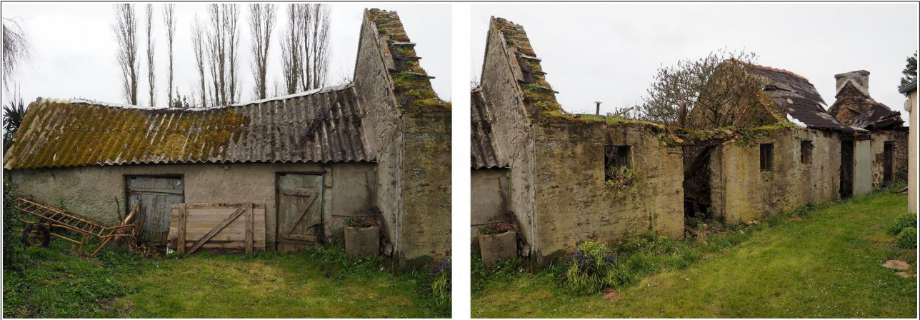
Ensemble des crèches et écuries actuellement à Kerlidec
