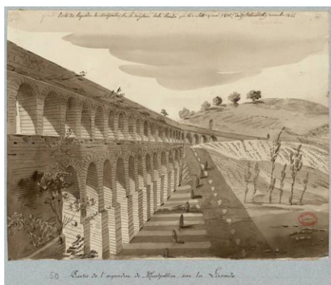
Amelin, Partie Aqueduc de Montpellier sur Lironde, Montferrier-sur-Lez, 1824-1844
