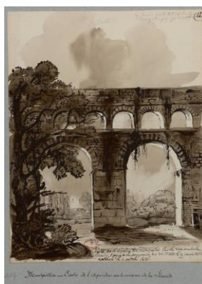
Amelin, Partie de l'Aqueduc sur ruisseau la Lironde, Montpellier, 1822-1836
