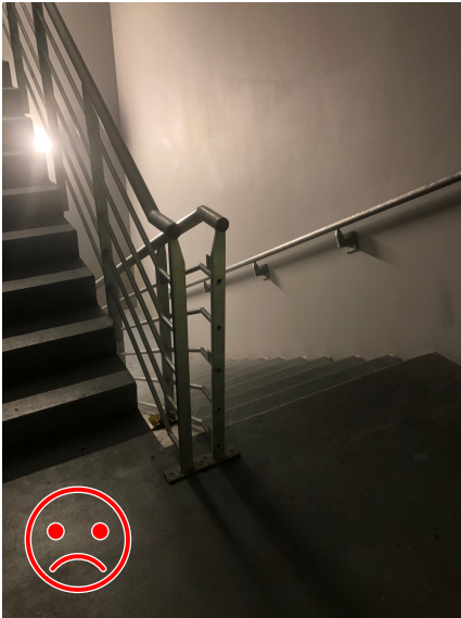
Figure 19 : Escalier menant aux étages de l'hôpital
