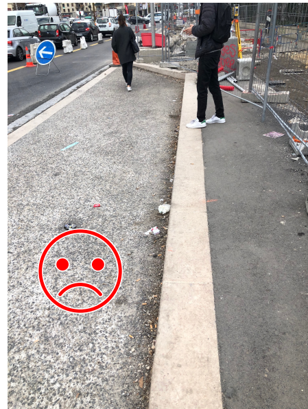
Figure 37 : Chemin dévié suite aux travaux en cours
