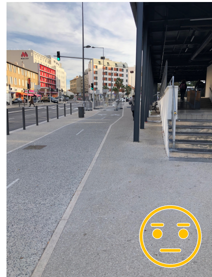
Figure 4 : Passage étroit entre la voie cyclable et l'armature du bâtiment
