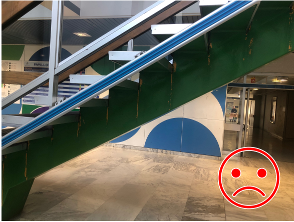
Figure 46 : Protection sous les escaliers
