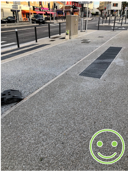
Figure 41 : Bandes podotactiles signalant la traversé de la voie cyclable
