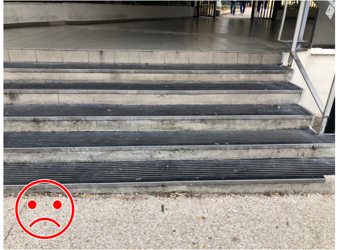
Figure 42 : Escalier menant à l'hôpital
