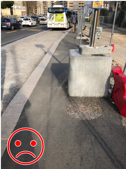
Figure 36 : Obstacle sur le cheminement extérieur
