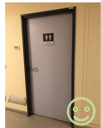
Figure 24 : Porte des toilettes couloir Timone 2
