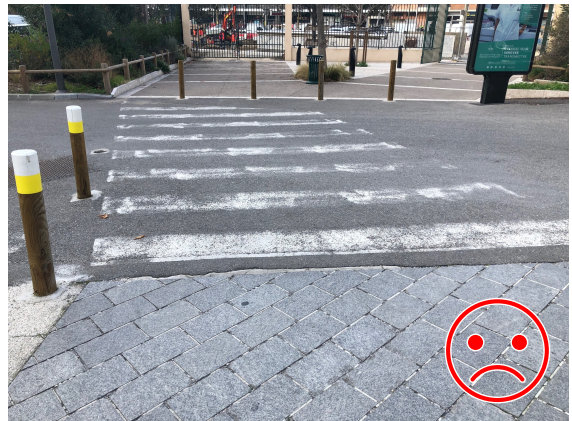
Figure 27 : Passage piéton vers la sortie
