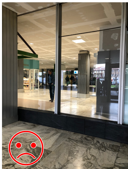
Figure 7 : Surface vitrée du sas d'entrée
