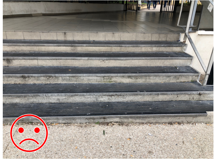
Figure 42 : Escalier menant à l'hôpital
