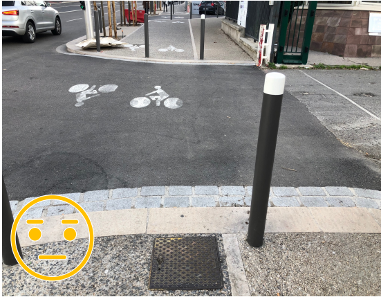
Figure 3 : Plots contrastés, absence de bandes podotactiles
