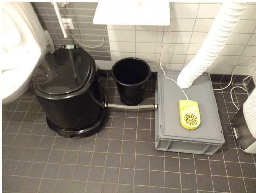
Figure 4 : Photographie du système de récupération de l'urine brute et sa transformation en urine alcalinisée déshydratée. Une toilette à séparation (à gauche) envoie l'urine brute dans la boîte grise (à droite) équipée d'un système de ventilation pour la déshydratation, et de chaux pour l'alcalinisation du produit.
