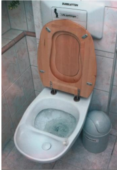
Figure 2 : Photographie d'une toilette à séparation en Suède (Johansson et al. , 2000).
