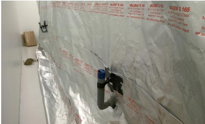
A l'arrière de la bulle, deux soupapes de surpression ont été installées. Ces tuyaux contiennent chacun une balle de ping-pong qui remonte quand il y a trop de pression à l'intérieur de la bulle. La balle est arrêtée par une sangle puis redescend et permet de réguler la pression.
