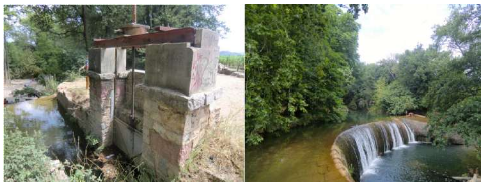
Figure 11: Ecluse du Canal Jean Natte (1456), localisé à l'aval du Gapeau
