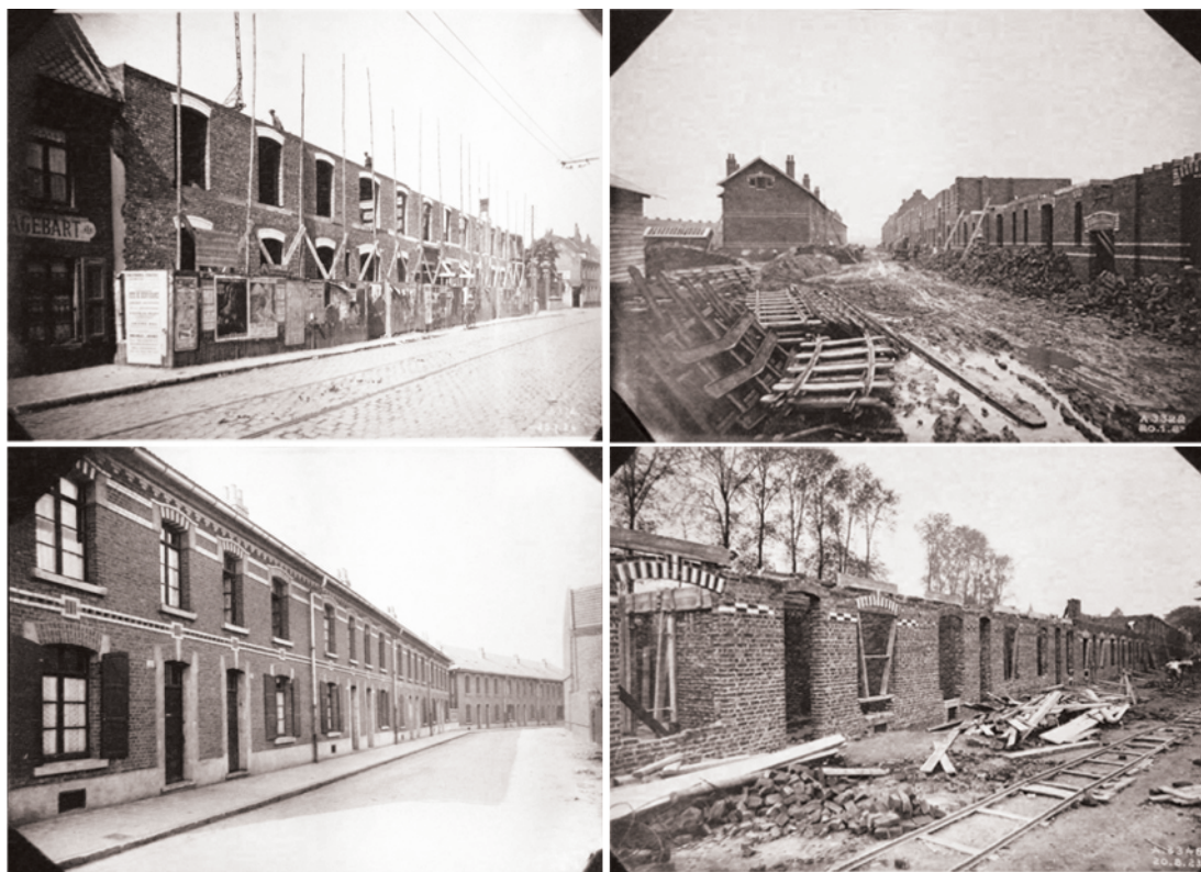
Photo de chantier de maisons 1930, © Archives du monde du travail, Roubaix
