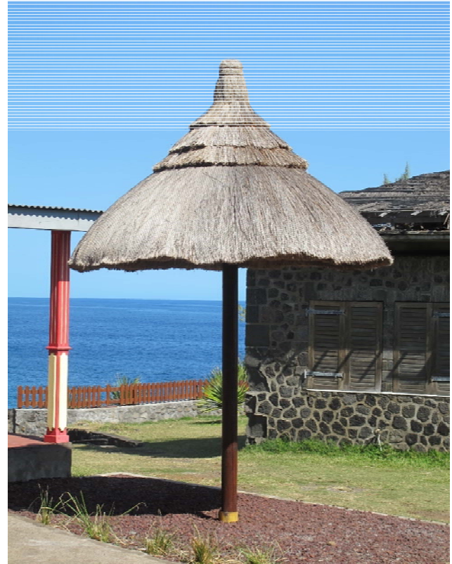
Kiosque toit en chaume de vétiver, Maison du Tourisme du Sud sauvage, La Réunion, 2013
