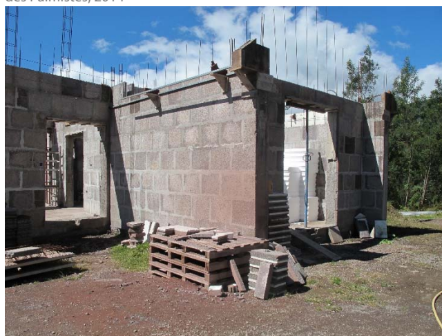
Chantier d'une maison utilisant la technique de coffrage perdu, La Plaine des Palmistes, 2014
