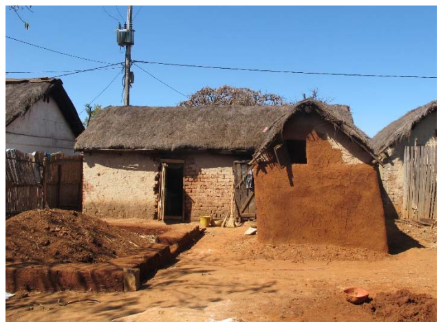
Habitat traditionnel à la périphérie d'Antsirabe – torchis, et adobes pour les murs, toit de chaume, 2013
