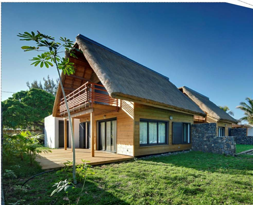
Condominium familiale 3 appartements La Réunion, 2013 TT Architecture
