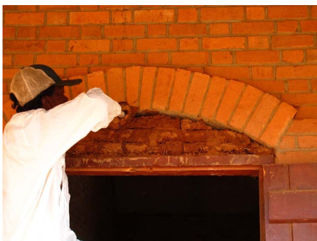
Maçonnerie de l'arc
