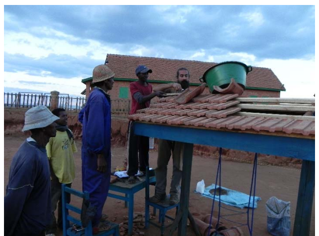
Pose des tuiles faitières
