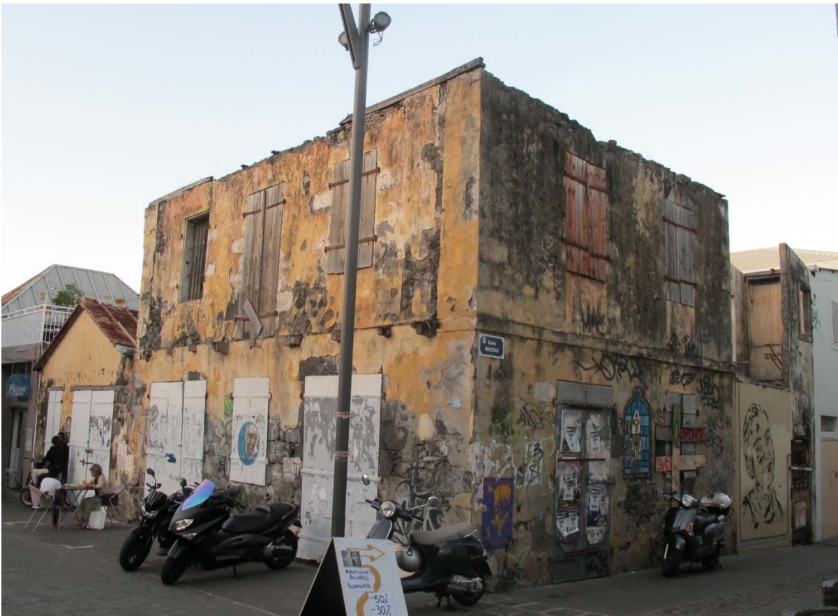
Bâti ancien, pierres de lave maçonnée, Saint-Denis, 2013
