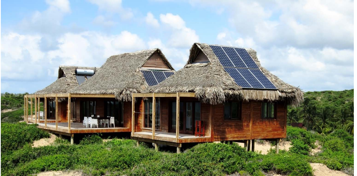
Maison Wessels, à Tofo, Mozambique, 2011, Timberdesign Le challenge fut d'intégrer des panneaux photovoltaïques et solaires à la toiture en chaume traditionnelle au Mozambique.
