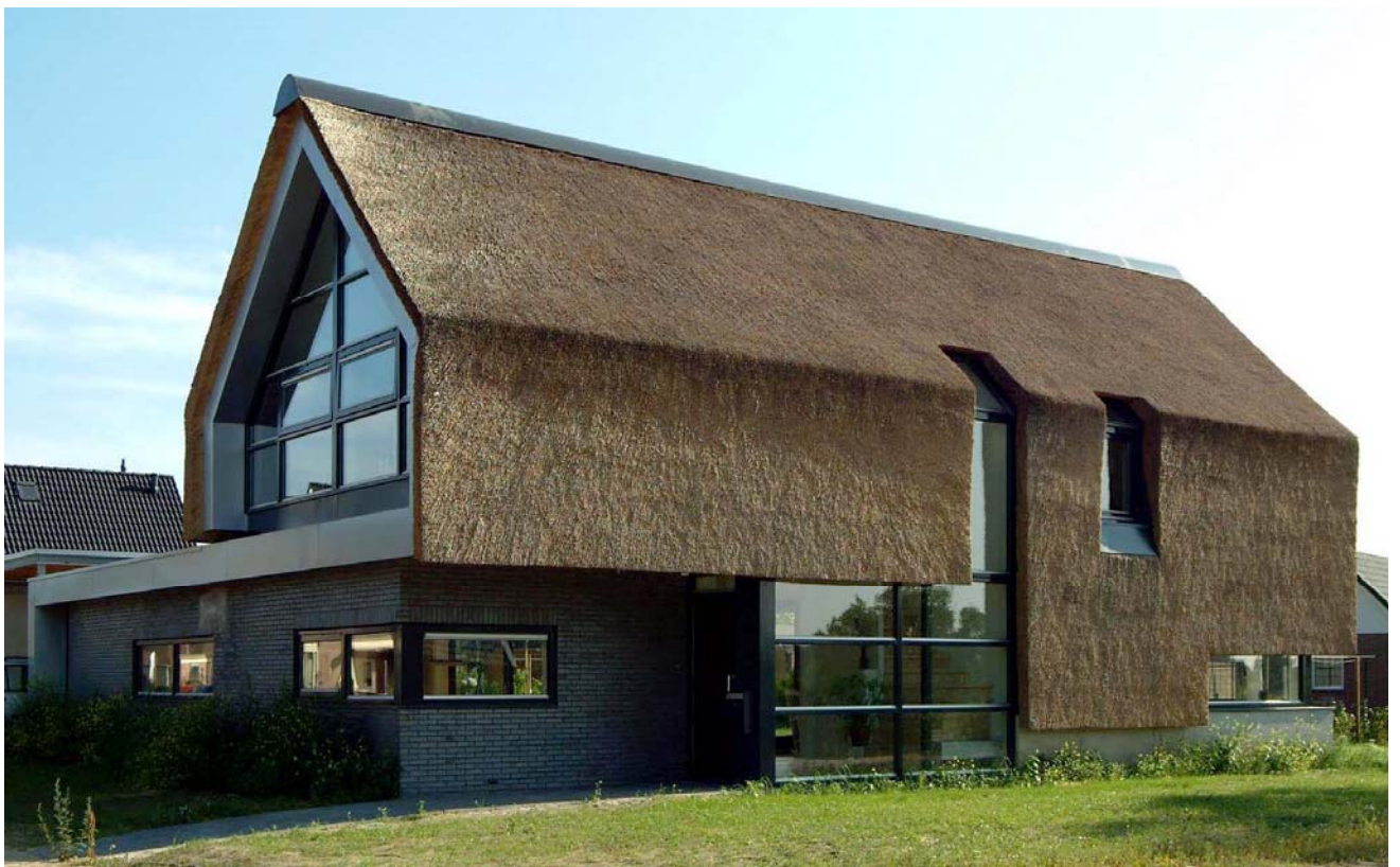
Maison à Gorssel, Pays Bas, Maas Architecten
