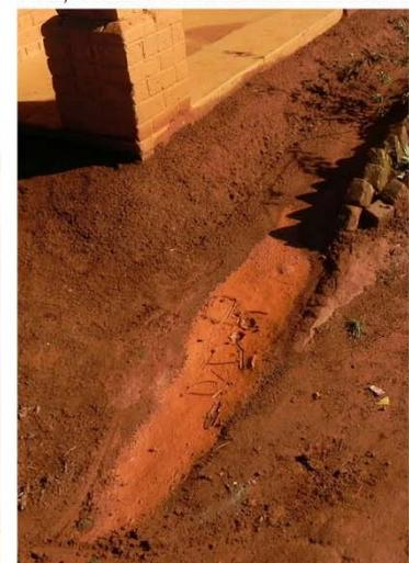
**L'Atelier remplissage des arcs** s'est déroulé sur la porte d'entrée de la salle de classe des 4èmes. Le remplacement des briques cuites du remplissage par des briques de terre-paille maçonnerées au mortier de terre puis enduites.
