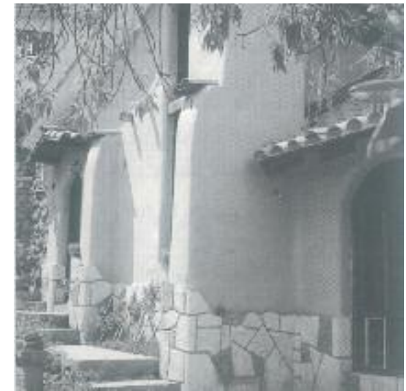
Fig. 133 Maison construite avec le Système constructif CET. (Olarte, Guzman, 1993)
