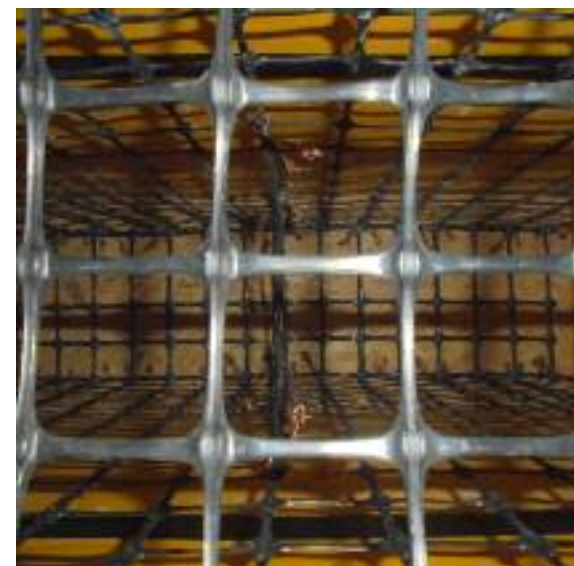
Fig. 221 Murets G,H. Les grilles placées horizontalement sont prises dans le béton en bas et en haut.
