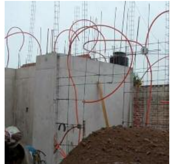
Fig. 122 Armature des murs. (Maxehterracreto 1, 2010)
