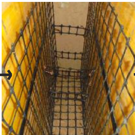
Fig. 156 Photo de renforcement avec grille pour muret en terre coulée.
