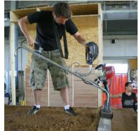
Fig. 42 Utilisation de règle vibrante dans une dalle de terre coulée. (photo: Caracol)
