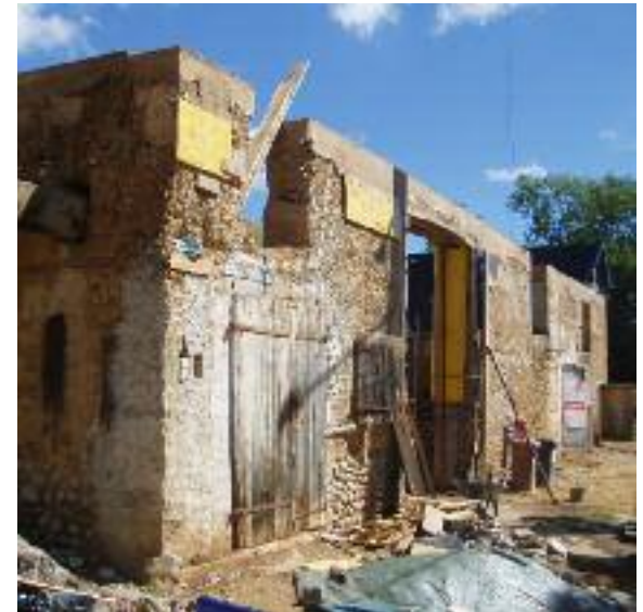
Fig. 273 Vue de la grange avec les arases finis en terre coulée.
