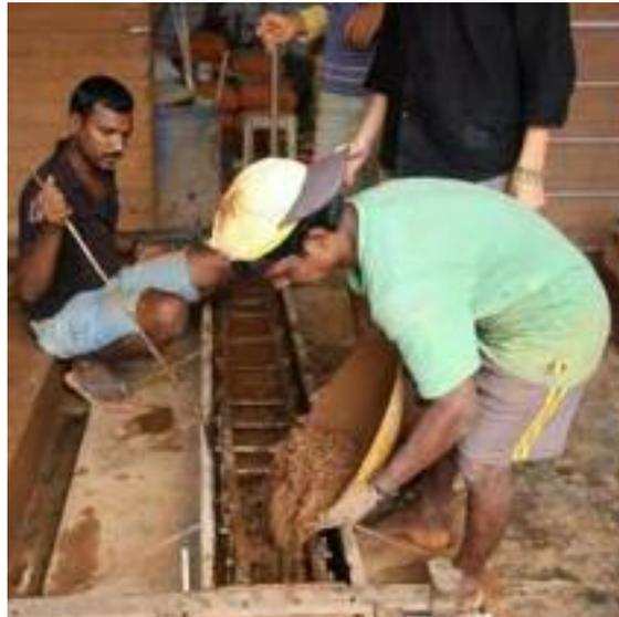
Fig. 140 Coulage de poutre en terre coulée avec armature double. (photo : Browne)(Browne, 2013. p.31)
