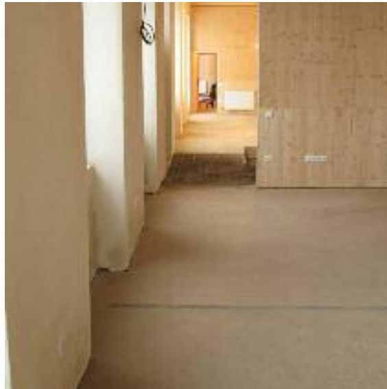
Fig. 300 Aspect de dalle terminée. (Argilus, 2014)
