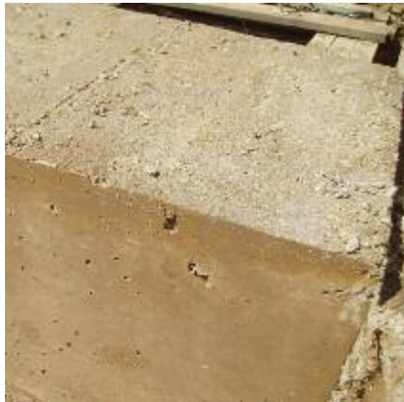
Fig. 272 Aspect fini d'une arase. On peut apprécier la surface lisse qui donne une planche à coffrage jaune.
