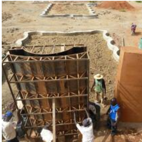
Fig. 285 Coffrage métallique de deux pièces en train d'être placé. On peut apprécier la forme courbe de l'élément coulé. (Holcim Foundation, 2014)
