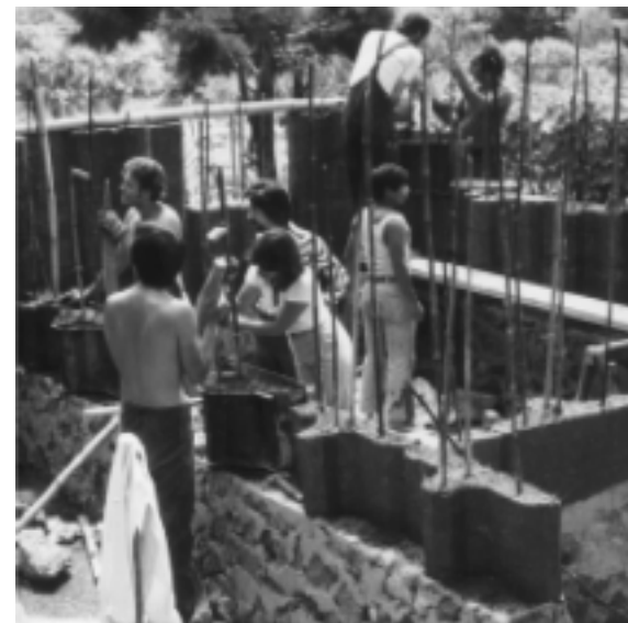
Fig. 82 Murs en construction avec renfortes internes. (Minke, 2001, p19-22)
