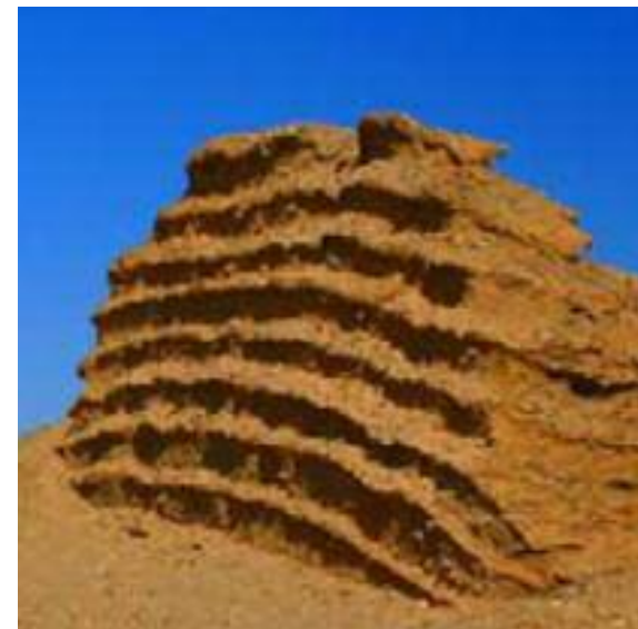
Fig. 53 Muraille de Chine, dans la section désert de Gobi, construit avec des lits de roseaux, sable et graviers (Anger, 2011, 55p)
