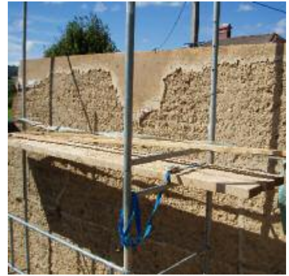
Fig. 270 Arase de terre coulée finie. On peut apprécier la ligne de l'union entre le pisé et la terre coulée.
