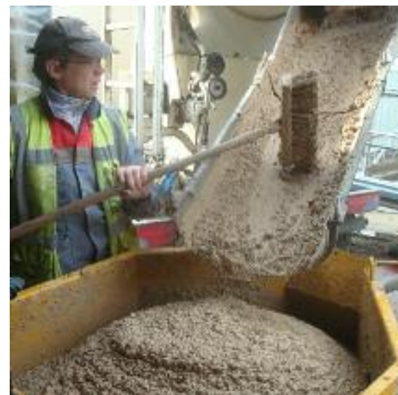
Fig. 278 Terre coulée qui sort du camion toupie et est versée à une veine de 500 litres.
