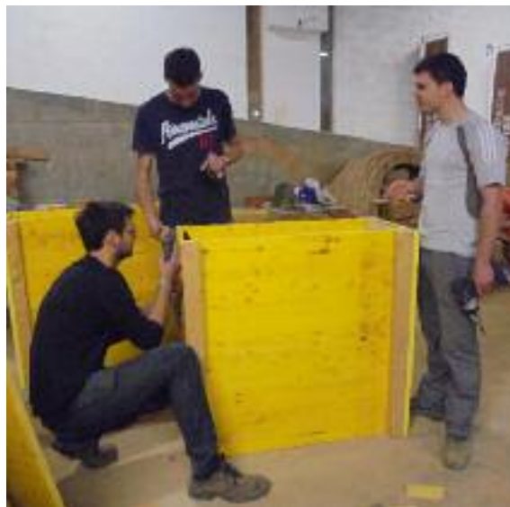
Fig. 222 Assemblage de panneaux de coffrage.
