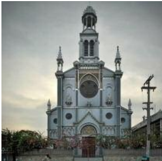
Fig. 110 Église à colombages en Haïti. (Langenbach, 2012)
