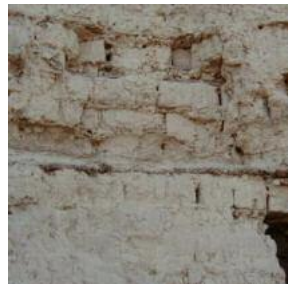
Fig. 55 Mur en adobe avec des lits de roseaux tous les cinq rangées, Ziggurat de Dur-Kurigalzu (photo: Silvia Reyes) (Anger, 2011, 55p)
