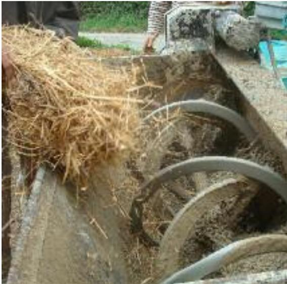
Fig. 28 Ajout de paille dans le mortier au chantier de Paladru, de l'entreprise Caracol.
