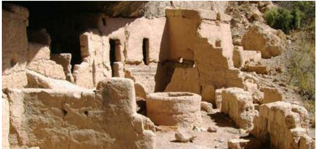
Fig. 22 Murs en terre coulée du site archéologique de Sirupa, région de Chihuahua au Mexique (photo: Guerrero)(Guerrero, 2011).
