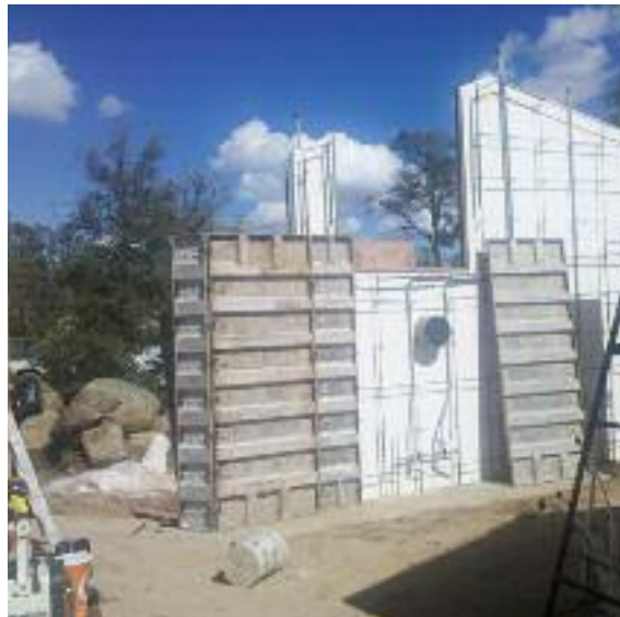
Fig. 147 Coffrage en train d'être posé. (photo : Michael Frerking)
