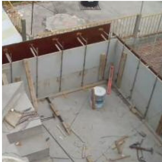
Fig. 121 Coffrage des murs. (Maxehterracreto 1, 2010)
