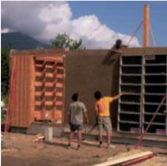
Fig. 37 Décoffrage de mur dans le chantier de Sasse-nage, de l'entreprise Caracol. (photo: Joris)
