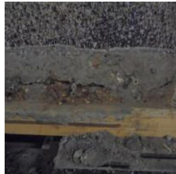
Fig. 237 Fissuration du muret dans l'axe des vis d'ancrage.
