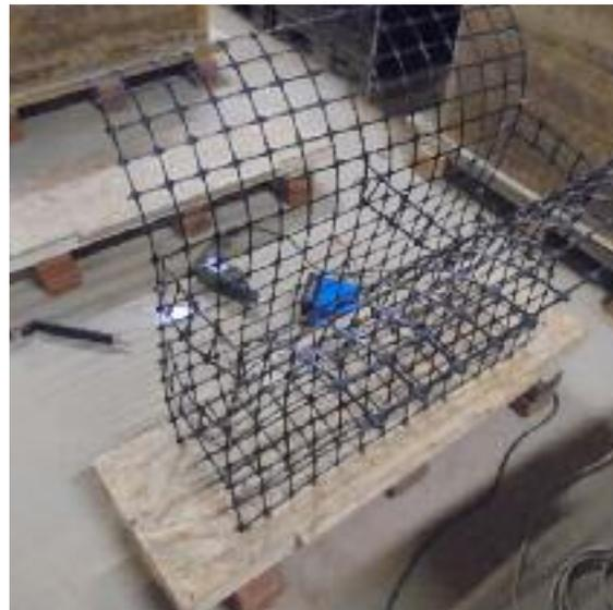
Fig. 224 Géogridde fixée avant le placement du coffrage.
