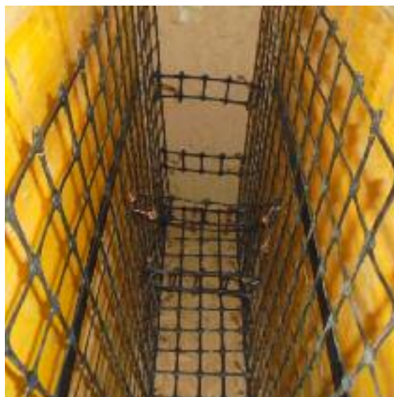
Fig. 220 Murs G,H. Des renforcements avec géogrille dans les deux faces longitudinales du murs. On a utilisé une géogrille TENAX 3d Grid XL rigidité a 0,5% déformation à 900MPa.
