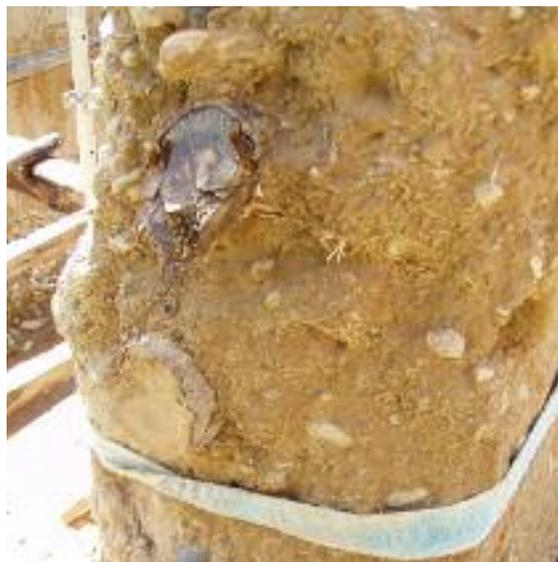
Fig. 54 Inclusions bois dans l'intersection de deux murs en pisé, dans une vieille grange près de Paladru, en Isère, pendant mon stage chez Caracol.
