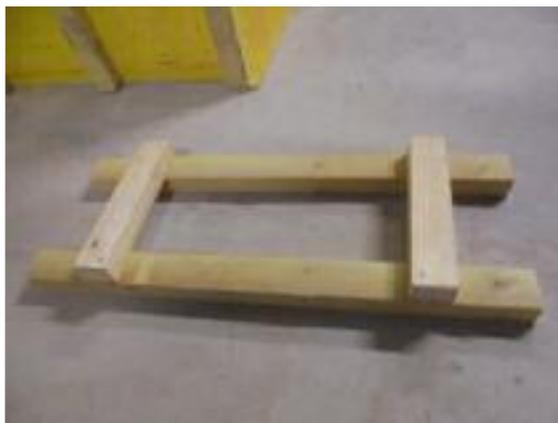
Fig. 218 Murets C,D. Photo d'une inclusion bois horizontale en forme d'échelle utilisée dans deux murs.
