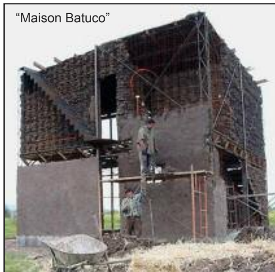
Fig. 202 Remplissage à la main avec un mortier de terre fibrée avec paille. (Cortés, 2012)
