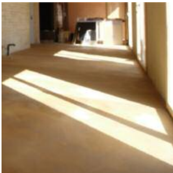
Fig. 258 Vue de la dalle en terre coulée armée finie. (B.A.E. 2013)
