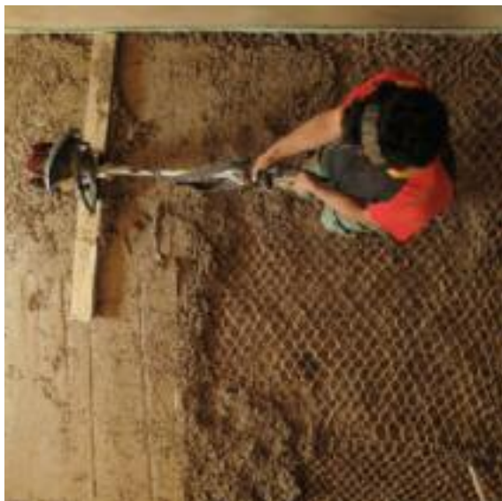
Fig. 255 Première couche armée avec la toile de coco. (B.A.E. 2013)
