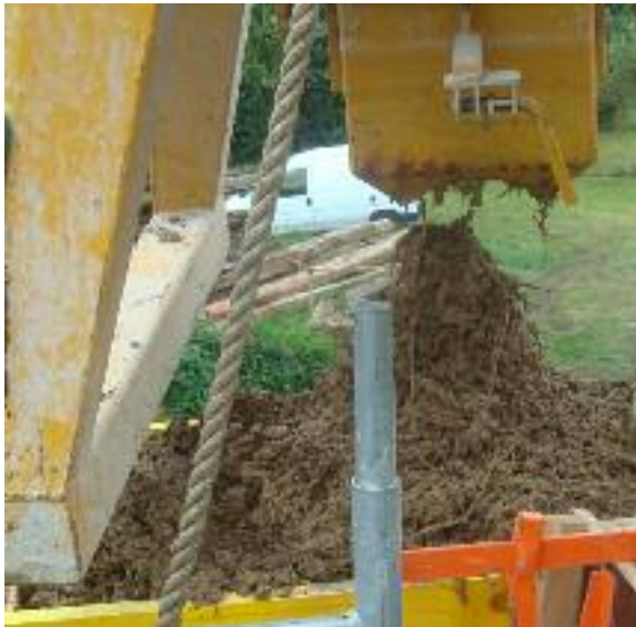
Fig. 271 Terre coulée fibrée avec de la paille. On peut apprécier l'état visqueux (presque plastique) du mélange.
