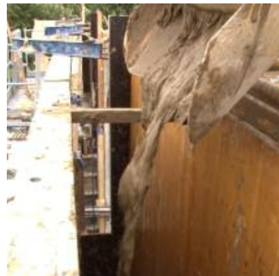
Fig. 307 Coulage du matériau. (Le Moniteur Tv)
