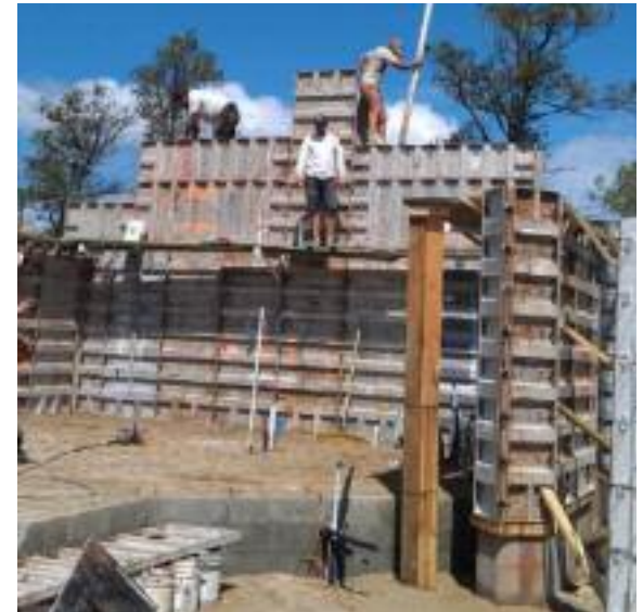
Fig. 148 Coulage des murs avec pompe. (photo : Michael Frerking)
