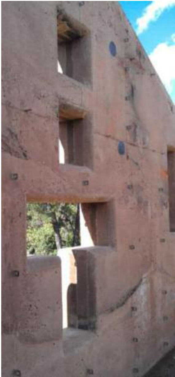
Fig. 149 Mur fini (photo : Michael Frerking)
