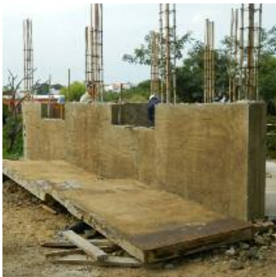
Fig. 136 Démouler de première banchée. (Aranda, 2014)
