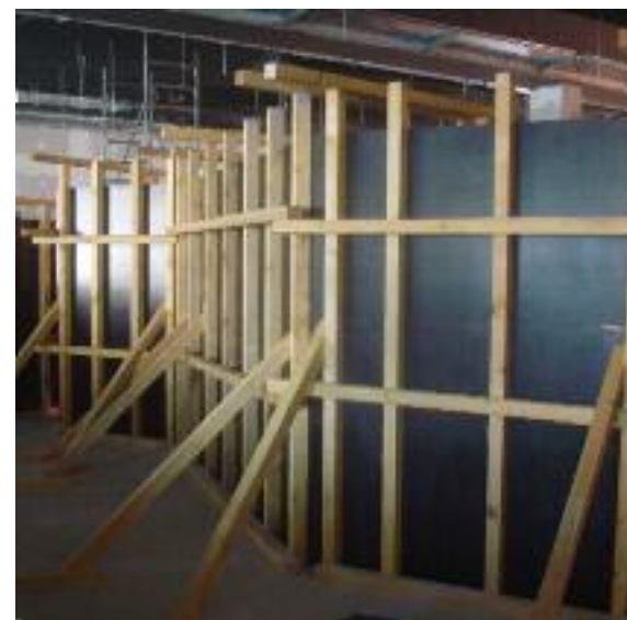
Fig. 276 Les modules plus hauts ont suivi la configuration du coffrage qui se montre dans ce photo.
