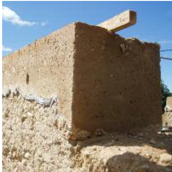
Fig. 269 Aspect fini d'une arase. On peut voir le pisé en bas et la terre coulée en haut.
