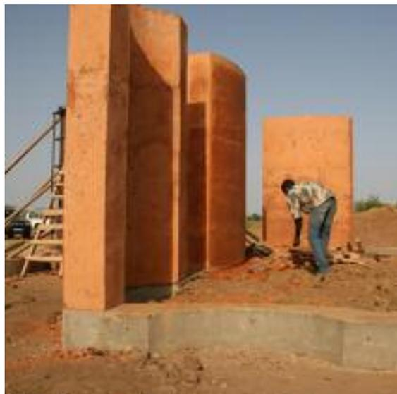
Fig. 288 Vue des murs décoffrés et de soubassement qui suit la forme des murs. (Holcim Foundation, 2014)
