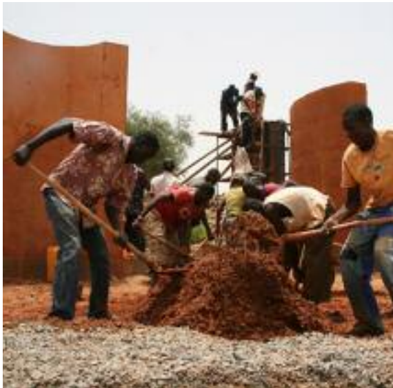
Fig. 287 Préparation à la main du mortier pour être transporté et coulé à la main également. (Holcim Foundation, 2014)
