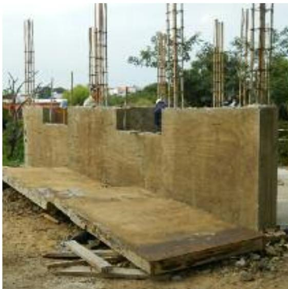
Fig. 136 Décoffrage de première banchée. (Aranda, 2014)
