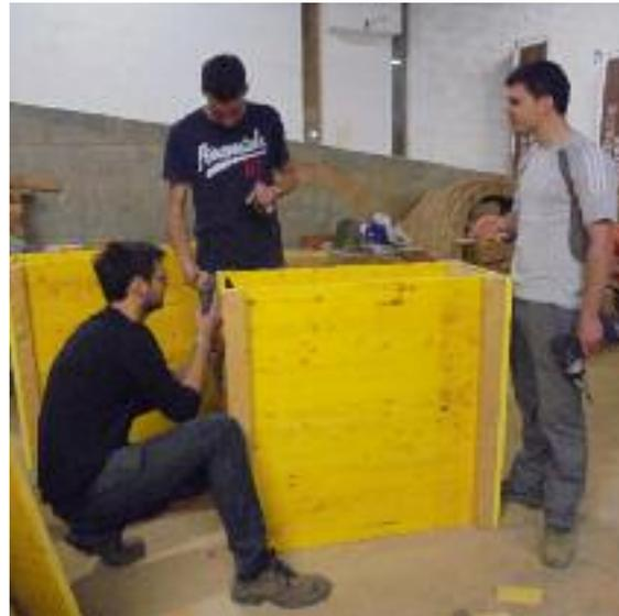
Fig. 222 Assemblage de panneaux de coffrage.
