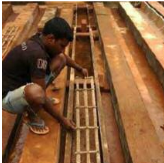
Fig. 138 Emplacement d'armature simple en bambou. (photo : Browne)(Browne, 2013. p.30)
