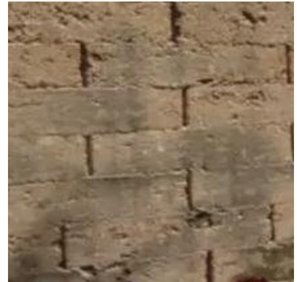
Fig. 24 Mur de terre coulée construit par l'architecte Elena Ochoa selon la tradition constructive de Tesisitan au Mexique. (El Guardian,2014)
