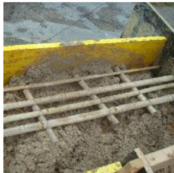
Fig. 267 Armature en grille de roseaux dans une arase.
