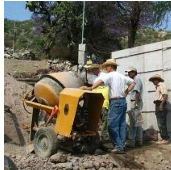
Fig. 292 Préparation du mortier à la bétonnière. (Maxeh, 2014)
