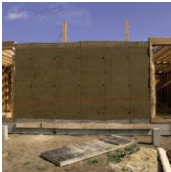
Fig. 262 Vue de la première partie du mur, un fois coulée. (B.A.E. 2013)
