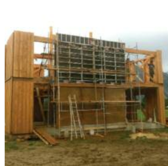
Fig. 263 Coffrage de la deuxième partie du mur à couler. (B.A.E. 2013)
