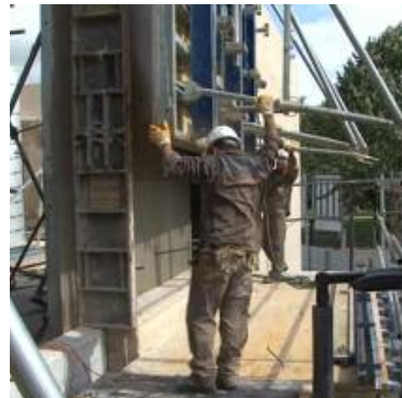
Fig. 305 Mis en place du coffrage. (Cematerre, 2014)
