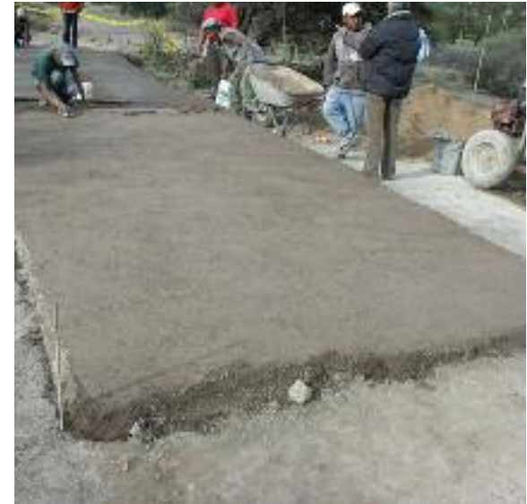
Fig. 299 Route en terre coulée. (Maxeh, 2014)
