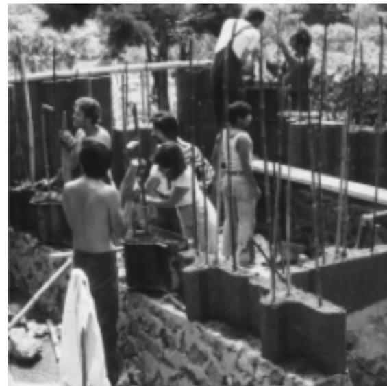
Fig. 82 Murs en construction avec renforts internes. (Minke, 2001, p19-22)
