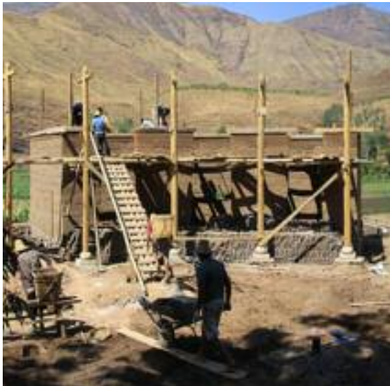
Fig. 89 Chantier en cours. (1u1v CUHK, 2013)
