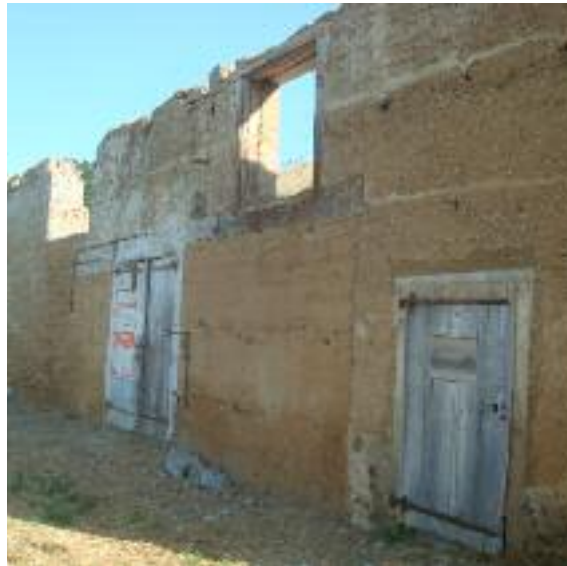
Fig. 264 Vue de la grange avant de purger les mur et de mettre en place le coffrage linéaire.
