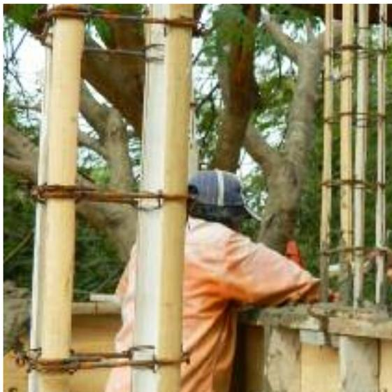
Fig. 134 Vue des renforts verticaux. Huit lames en bambou sont attachées entre eux par des anneaux en acier. (Aranda, 2014)
