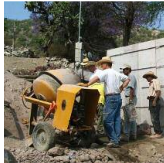
Fig. 292 Préparation du mortier à la bétonnière. (Maxeh, 2014)
