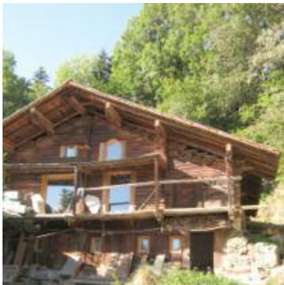
Fig. 251 Vue de la maison en Hautes Luce où Caracol a construit une dalle en terre coulée. (B.A.E. 2013)
