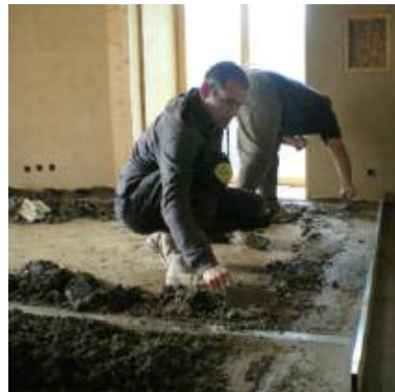
Fig. 256 Deuxième couche mise en œuvre de manière conventionnelle. (B.A.E. 2013)
