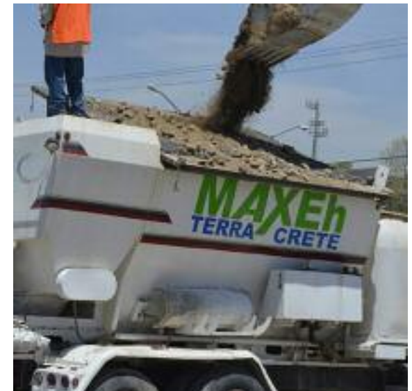
Fig. 293 Camion malaxeur de l'entreprise. (Maxeh, 2014)
