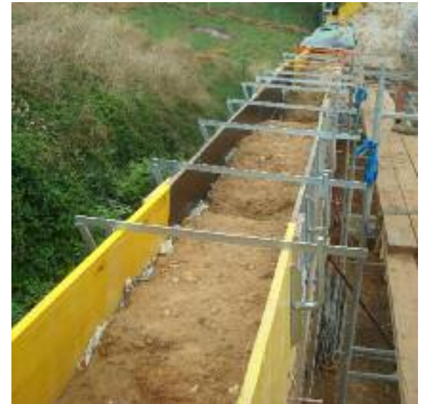
Fig. 265 Coffrage linéaire prêt.
