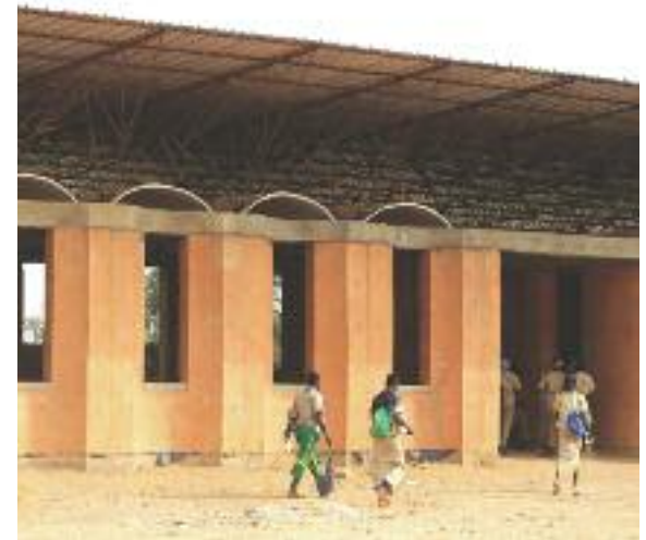
Fig. 286 Vue d'une façade. On peut apprécier la double toiture. (Holcim Foundation, 2014)
