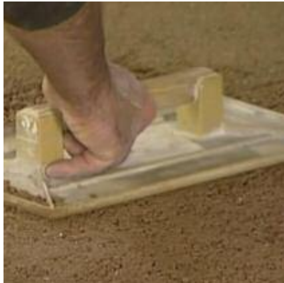
Fig. 41 Utilisation de la taloche. (Argilus, 2014)
