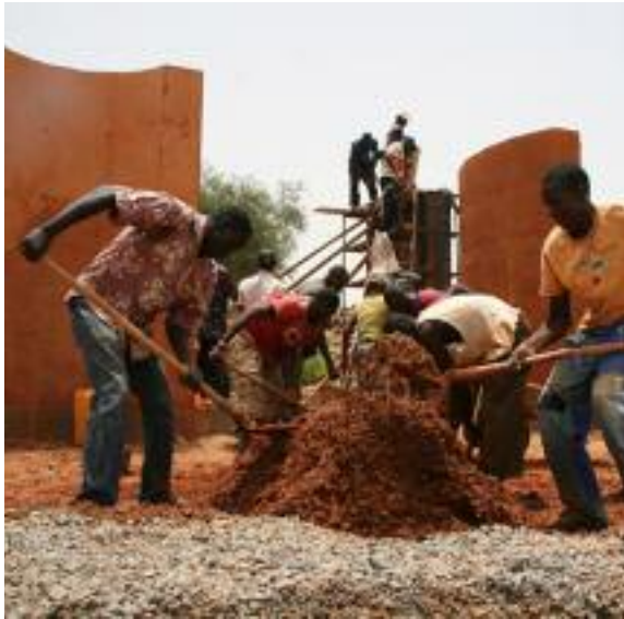
Fig. 25 Préparation à la main du mortier pour être transporté et coulé à la main également. (Holcim Foundation, 2014)
