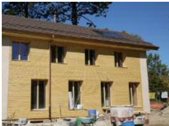
Fig. 257 Maison en paille porteuse et ossature bois-bottes de paille de CaRpe Architectures. Cette maison a été construite dans sa quasi totalité en chantier participatif. (B.A.E. 2013)
