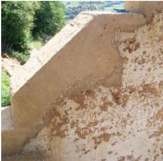
Fig. 268 Arase inclinée dans un coin d'un mur. La terre coulée permet ce type de finitions.
