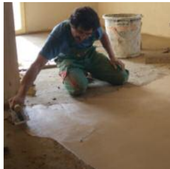
Fig. 259 Troisième couche appliquée à la lisseuse japonaise. (B.A.E. 2013)
