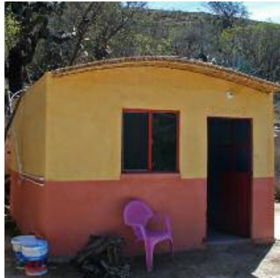
Fig. 290 Maison en terre coulée dans un village de Allende, région de Guanajuato au Mexique. (Maxeh, 2014)
