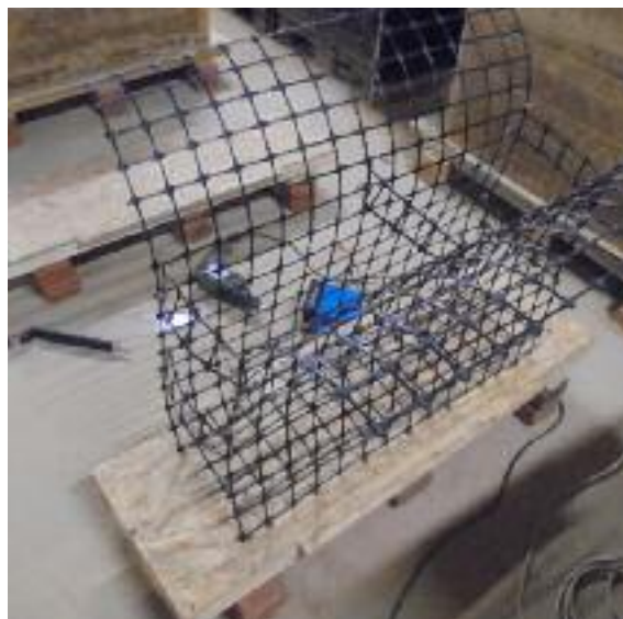
Fig. 224 Géogrille fixée avant le placement du coffrage.
