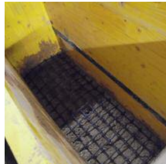
Fig. 219 Murets E,F. Cette image montre un renforcement horizontal de géogrille en plastique.
