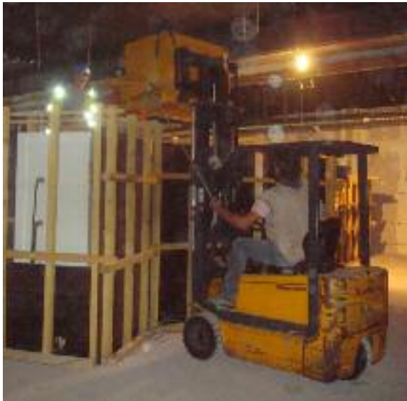
Fig. 282 Manitou en train de verser le matériau dans un coffrage.
