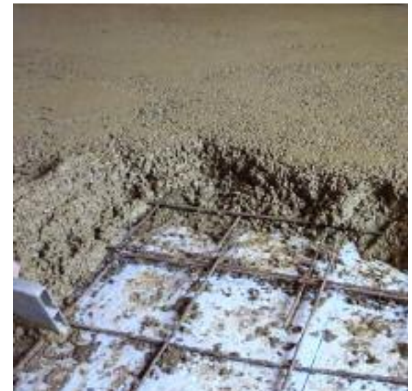
Fig. 303 Les dalles peuvent être armées, comme les dalles ordinaires. (Argilus, 2014)
