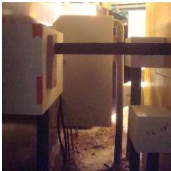
Fig. 277 Vue des niches en polystyrène, avec des tuyaux de ventilation et des installations électriques à l'intérieur d'un autre module.
