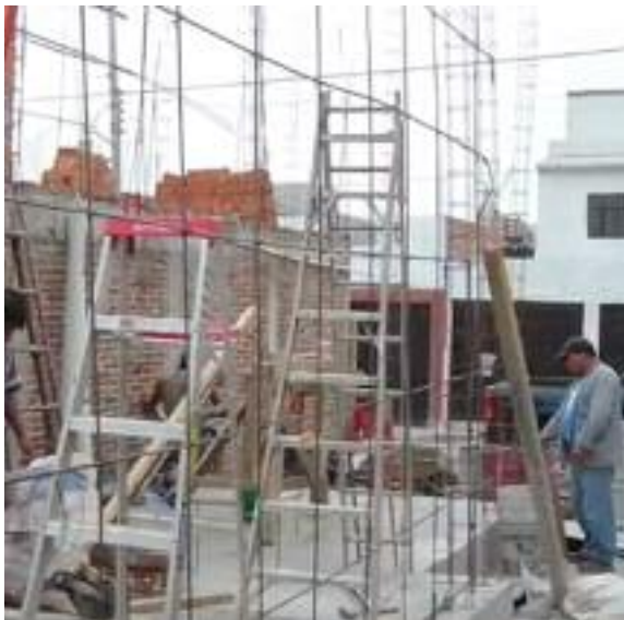
Fig. 120 Armature des murs. (Maxehterracreto 1, 2010)
