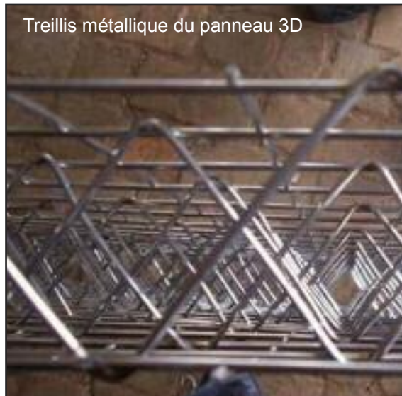
Fig. 199 Cette photo montre un treillis métallique du panneau 3D, qu'illustre le dessin précédent. (Pics&Fotos, 2014)
