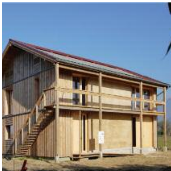
Fig. 260 Façade sud de la maison avec le mur en terre coulée. (B.A.E. 2013)
