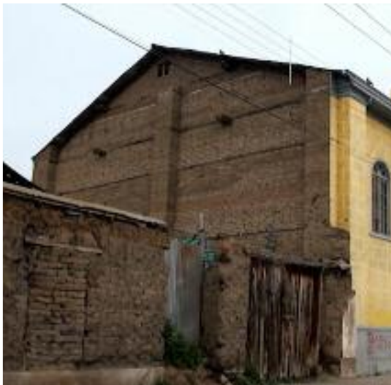
Fig. 94 Construction en adobe avec des renforcements horizontaux. (Rivera, Muñoz, 2012)
