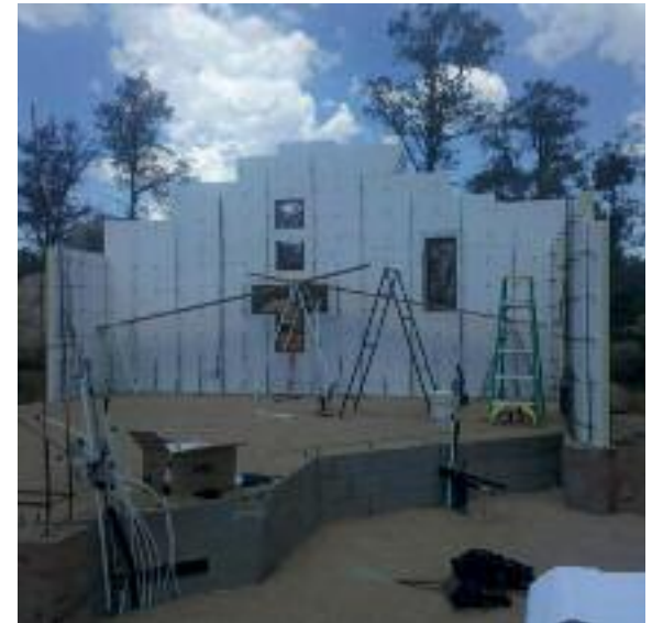
Fig. 146 Vue d'armatures de tige d'acier et des plaques d'isolant thermique. (photo : Michael Frerking)
