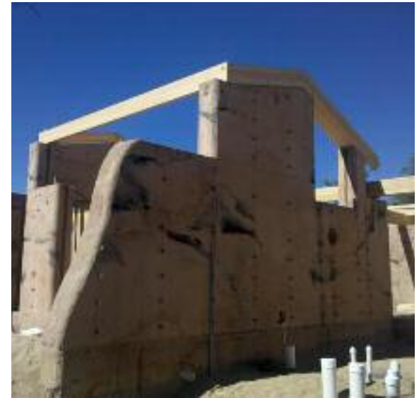
Fig. 152 Mur fini (photo : Michael Frerking)
