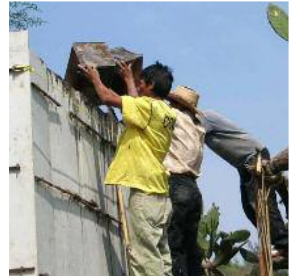
Fig. 291 Versement du mortier aux seaux. (Maxeh, 2014)
