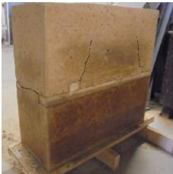
Fig. 228 Fissures du rétrécissement du muret C du à l'inclusion bois.
