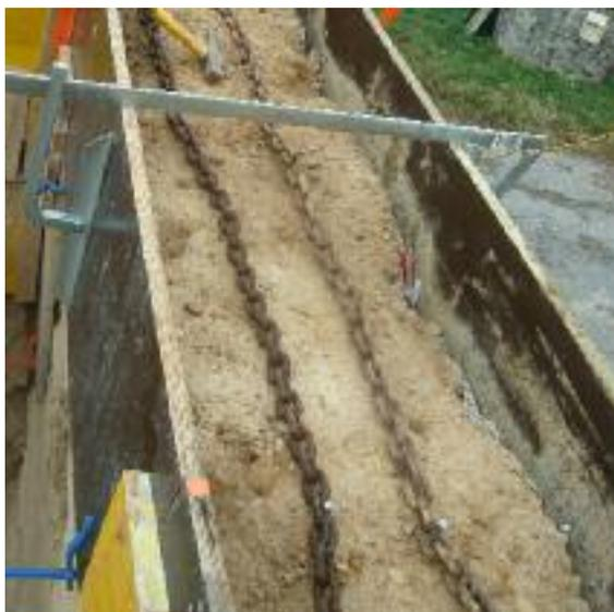
Fig. 266 Vieilles chaînes métalliques clouées à une tête de mur avant le coulage.
