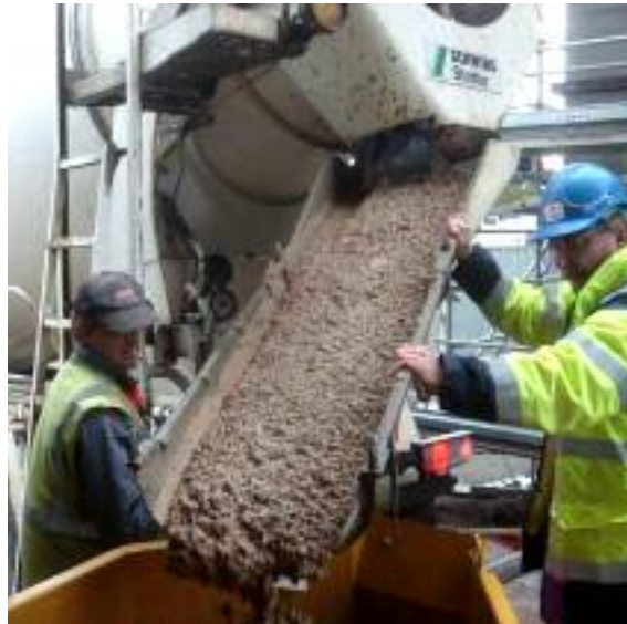
Fig. 35 Camion toupie en train de verser de la terre coulée, dans le chantier de la Maison du Marais, de l'entreprise Caracol.
