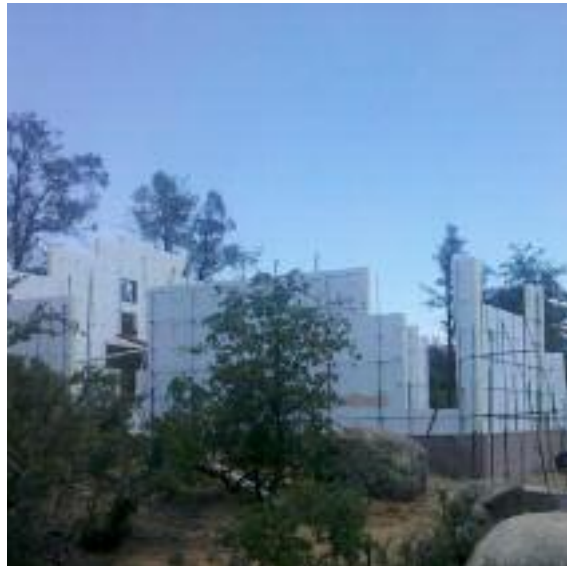
Fig. 145 Vue d'armatures de tige d'acier et des plaques d'isolant thermique. (photo : Michael Frerking)
