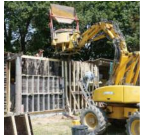
Fig. 33 Coulage de mur avec malaxeur planétaire dans le chantier de à Saint Didier de l'entreprise Caracol. (Moevus, B.A.E., 2013)
