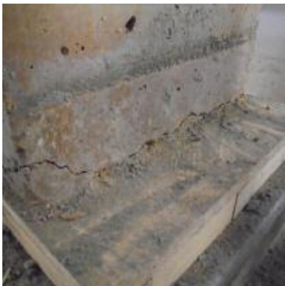
Fig. 238 Fissuration du muret dans l'axe des vis d'ancrage.
