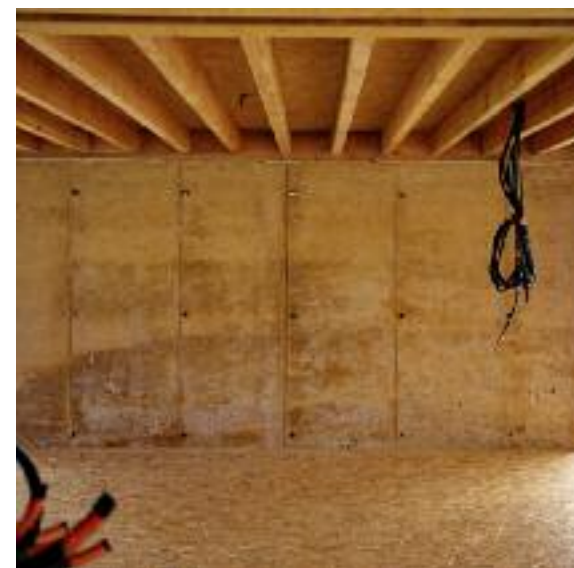
Fig. 261 Vue du mur en terre coulée de l'intérieur de la maison. (B.A.E. 2013)
