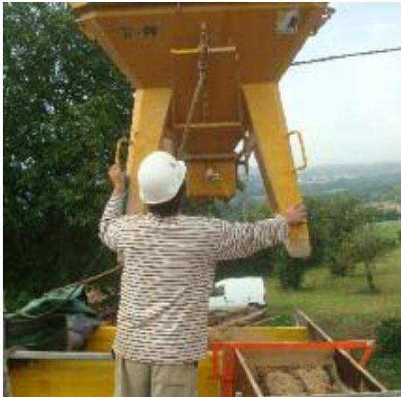
Fig. 31 Godet verseur utilisé au chantier de Paladru, de l'entreprise Caracol.
