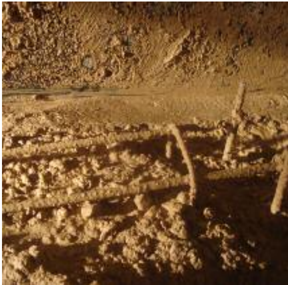
Fig. 279 Ferrailage avec des fers à béton de quelques parties des modules.
