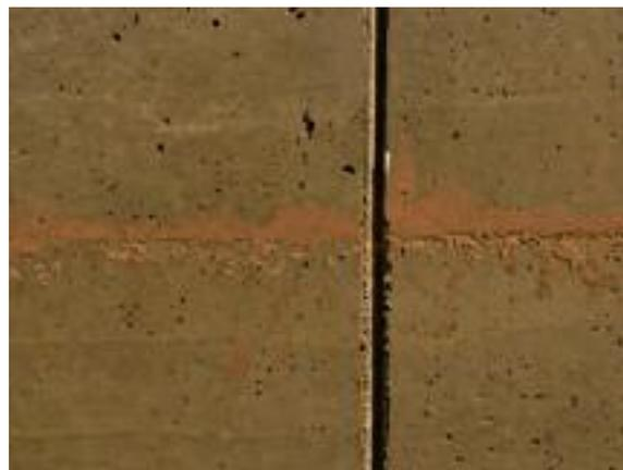
Fig. 262 Joint de dilatation du mur et aspect du mur. (Caracol, 2013)
