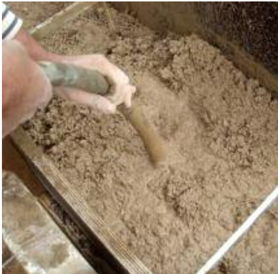
Fig. 34 Vibration de mélange pendant le chantier de Paladru, de l'entreprise Caracol.
