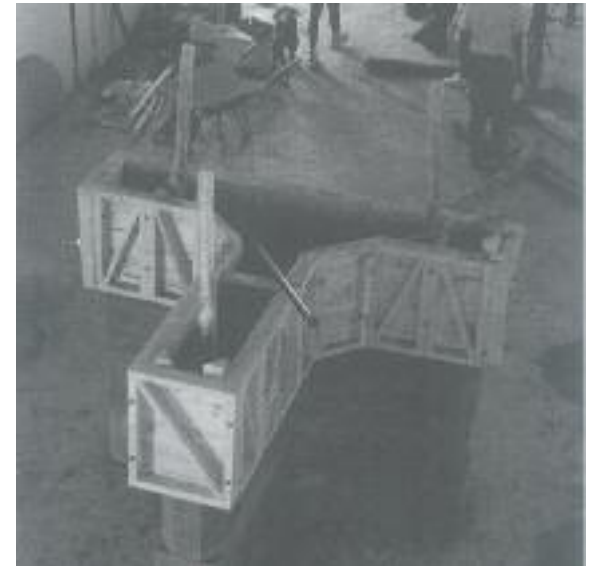
Fig. 132 Murs en pisé en construction avec des inclusions bois. (Olarte, Guzman, 1993)
