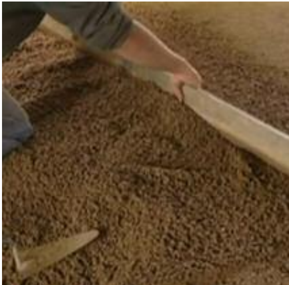
Fig. 40 Utilisation de la règle. (Argilus, 2014)
