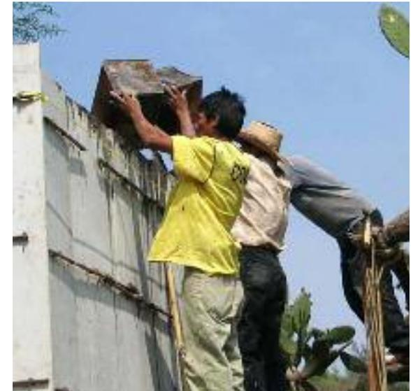
Fig. 291 Versement du mortier aux seaux. (Maxeh, 2014)
