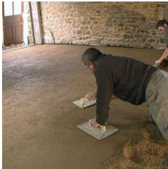
Fig. 302 Application du produit à la règle et à la taloche. (Argilus, 2014)
