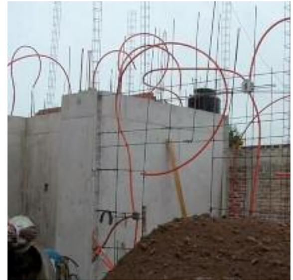
Fig. 122 Armature des murs. (Maxehterracreto 1, 2010)
