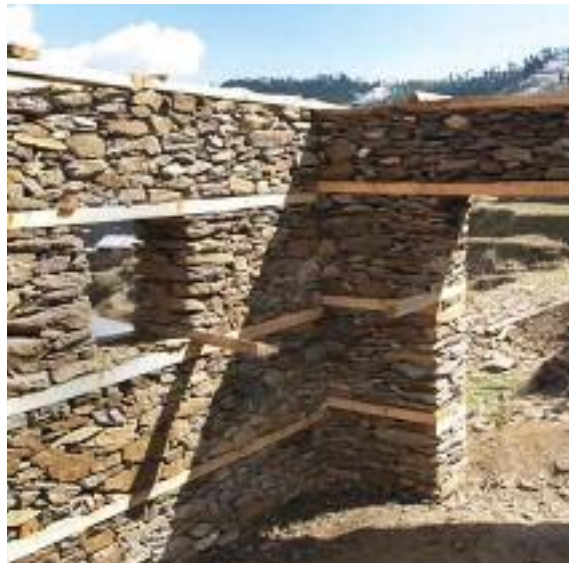
Fig. 98 Nouvelle construction au Pakistan avec renforcement horizontal. (Langenbach, 2012)
