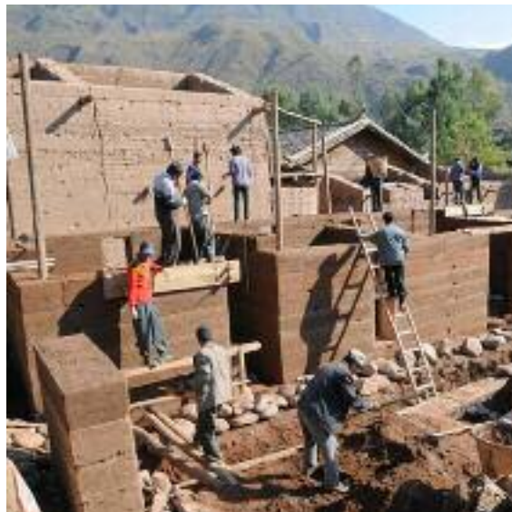
Fig. 90 Chantier en cours. (1u1v CUHK, 2013)
