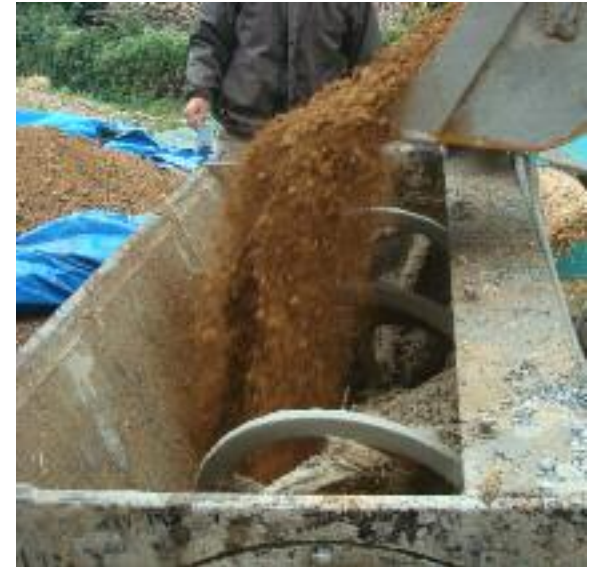
Fig. 27 Malaxeur utilisé au chantier de Paladru, de l'entreprise Caracol.
