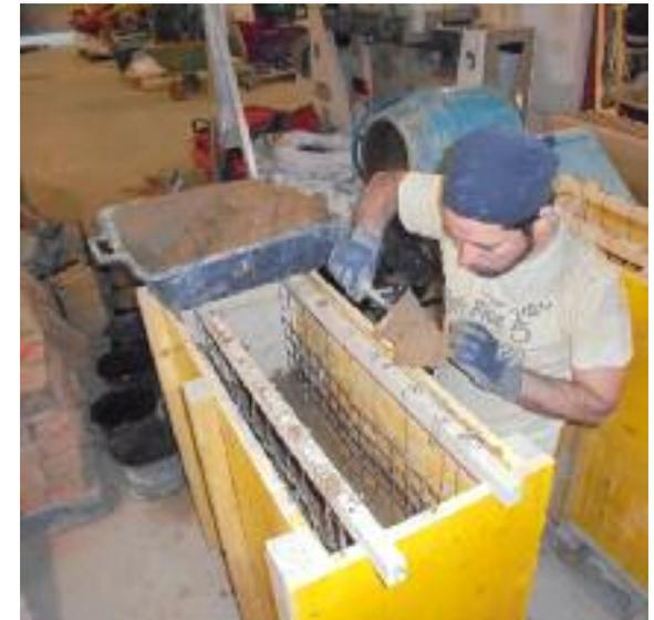
Fig. 225 Fixation des géogriddes aux tasseaux bois et remplissage à la truelle entre les faces du coffrage et la géogridde.
