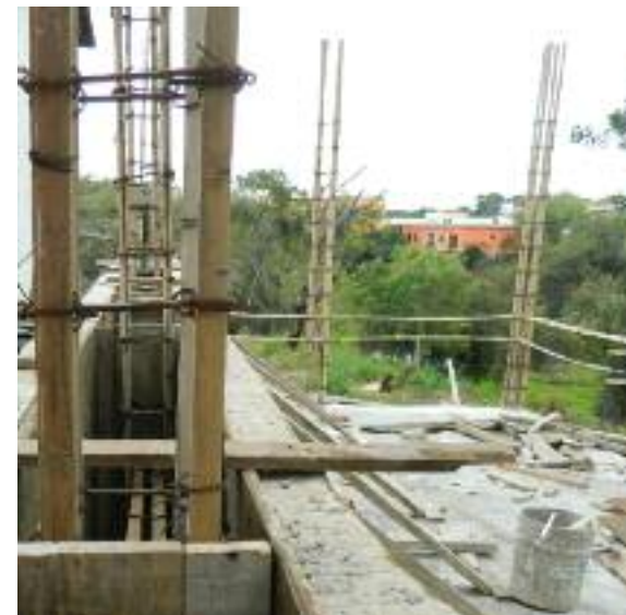
Fig. 135 Des paires de renforts horizontaux en bambou sont placées à chaque 60 centimètres. (Aranda, 2014)
