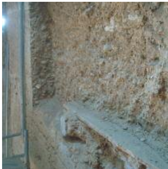
Fig. 52 Planche en bois trouvé pendant le percement d'une ouverture dans un mur en pisé en Chimilin en Isère; pendant mon stage chez Caracol.
