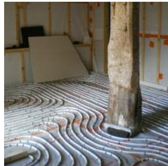
Fig. 252 Tuyaux chauffants avant le coulage de la dalle. (Joris, 2011)
