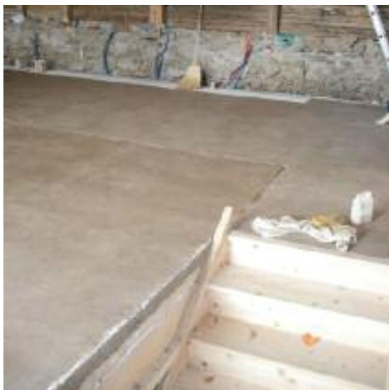
Fig. 253 Vue de la dalle en terre coulée finies. (B.A.E. 2013)
