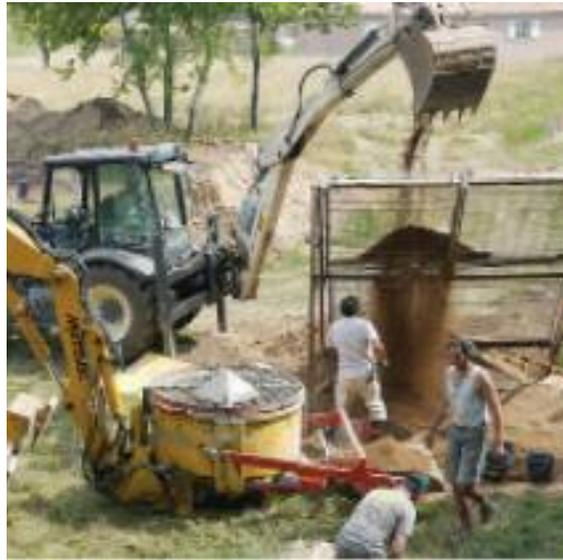
Fig. 29 Malaxage et criblage dans le chantier de à Saint Didier de l'entreprise Caracol. (Moevus, B.A.E., 2013)
