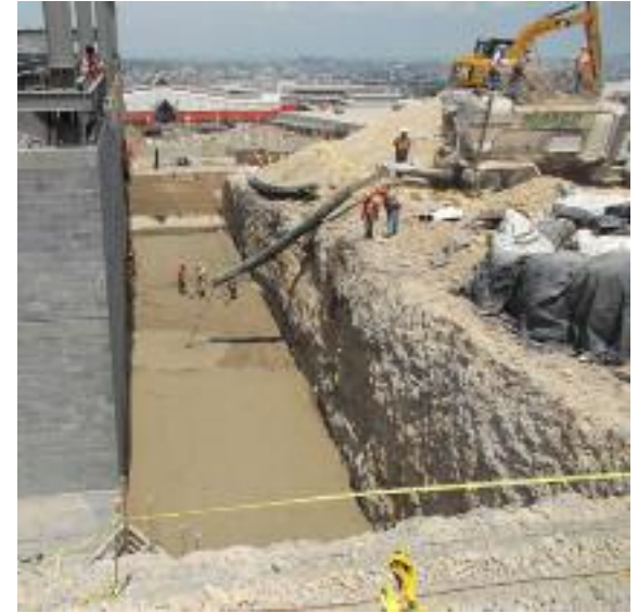
Fig. 296 Coulage d'un grand volume. (Maxeh, 2014)
