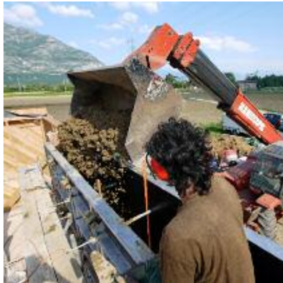
Fig. 32 Coulage de mur dans le chantier de Sasse-nage, de l'entreprise Caracol. (photo: Joris)
