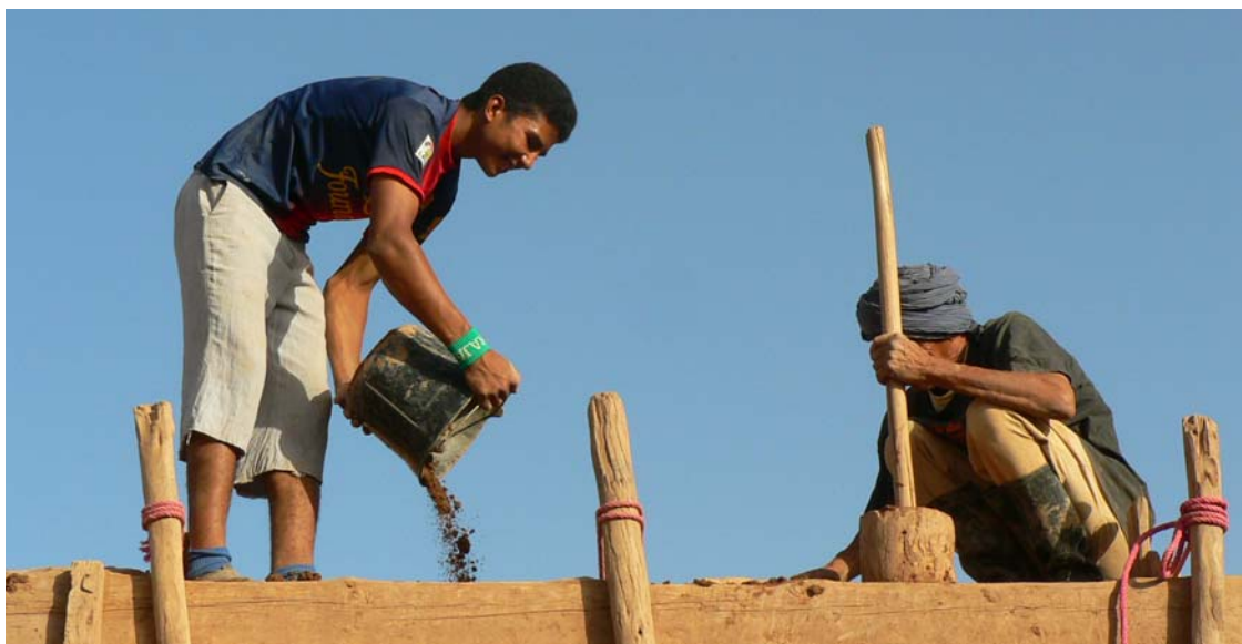
Transmission générationnelle de la technique traditionnelle en pisé
