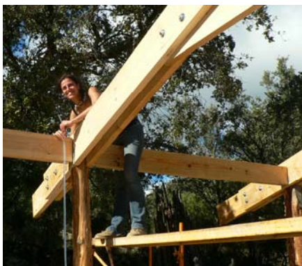
Installation des poutres
