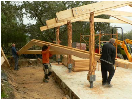
Mise en place des fermes
