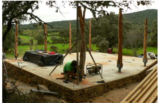
Poteaux de genévrier (technique vernaculaire) installés
