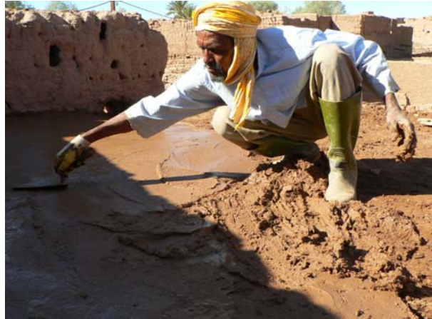
Création de la pente pour évacuer l'eau de la toiture
