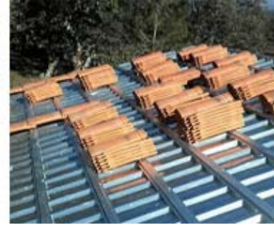
Isolation en laine vierge de mouton Tôle métallique et omégas d'installation des tuiles
