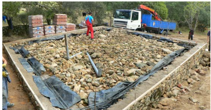
Préparation pour couler la dalle
