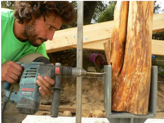
Boulonnage des poteaux
