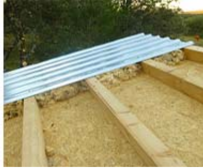
Isolation en laine vierge de mouton Tôle métallique et omégas d'installation des tuiles
