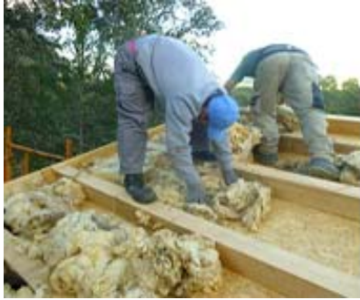
Isolation en laine vierge de mouton Tôle métallique et omégas d'installation des tuiles
