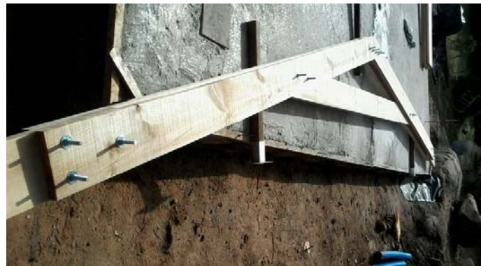
Duplication et boulonnage du reste de fermes
