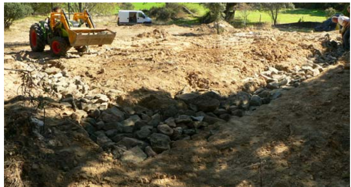
Remplissage de fondations
