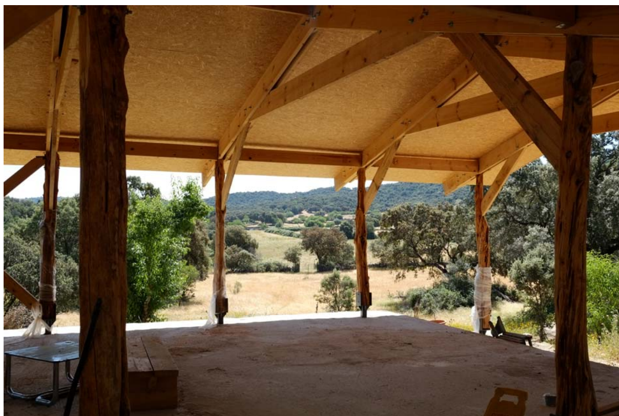
État de la structure en 2014
