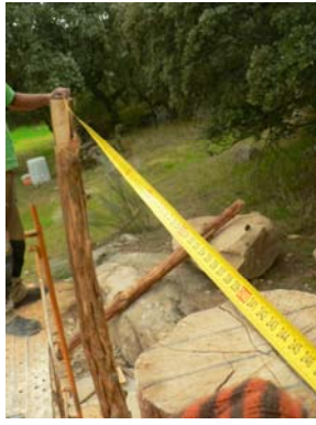
Alignement des poteaux
