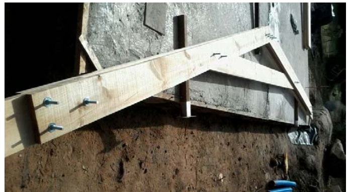
Duplication et boulonnage du reste de fermes
