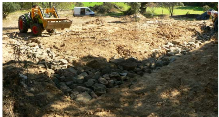
Remplissage de fondations
