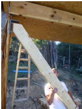
Appuis des contreventements - Installation des contreventements transversaux et longitudinaux
