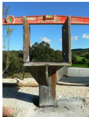
Pose nivelée d'appui
