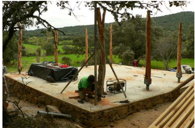
Poteaux de genévrier (technique vernaculaire) installés
