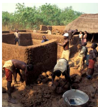
Construction en Bauge, Bénin
