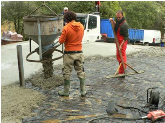
Coulage de la dalle en béton et mise en place des plaques d'appui
