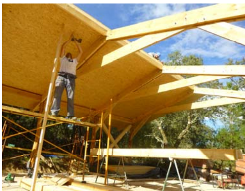
Installation des plaques d'OSB et des pannes
