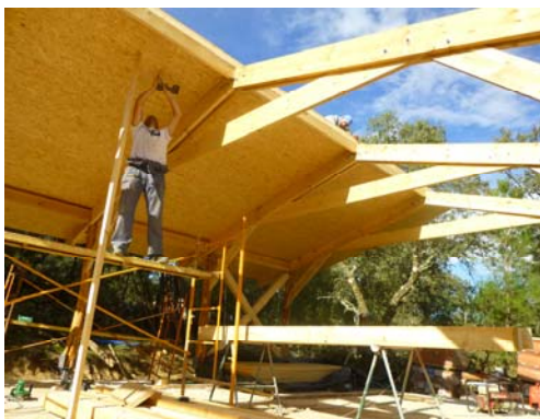
Installation des plaques d'OSB et des pannes
