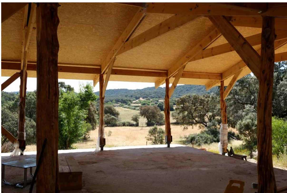
État de la structure en 2014
