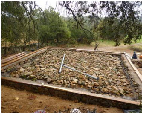
Chaînage périphérique et remplissage en pierres
