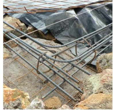
Plaque d'appui de pilier encastré dans la semelle
