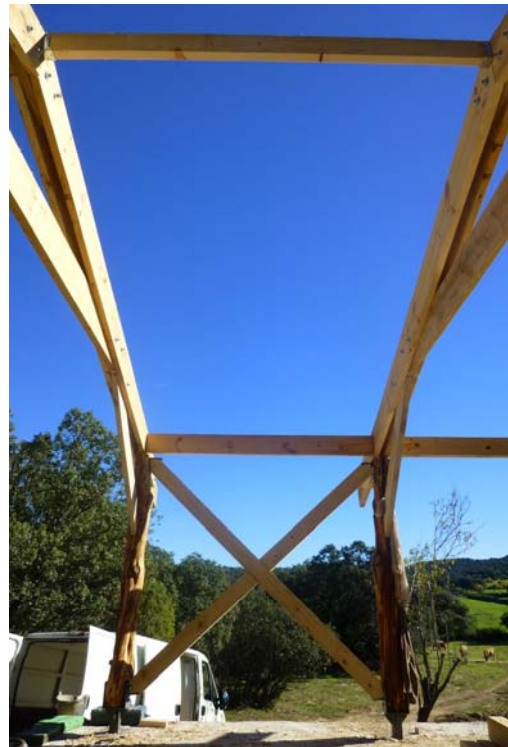
Appuis des contreventements - Installation des contreventements transversaux et longitudinaux
