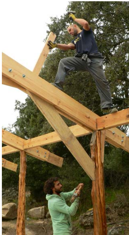
Appuis des contreventements - Installation des contreventements transversaux et longitudinaux
