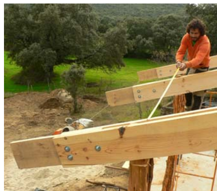
Vérification des distances entre fermes
