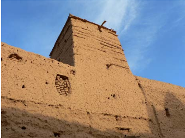
Renforcement des murs
