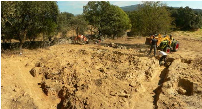
Traçage au sol et excavation
