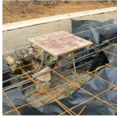
Plaque d'appui de pilier encastré dans la semelle
