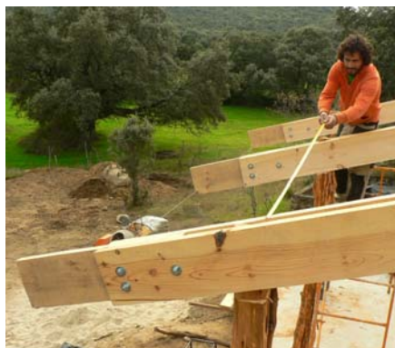
Vérification des distances entre fermes
