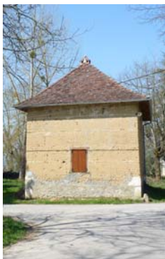
Bâtisse en pisé, France
