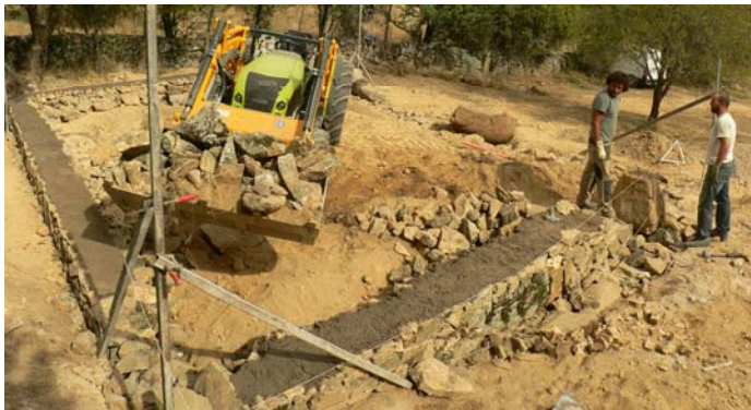
Murs de soubassement et remplissage intérieur
