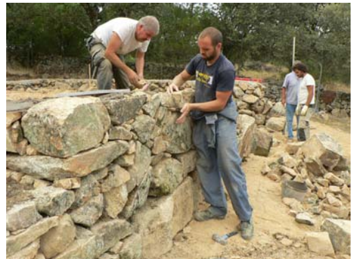
Murs en pierre sèche (technique locale)
