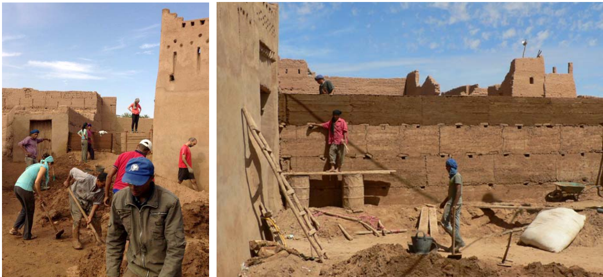
Travaux de reconstruction de la Porte du Ksar Ouled Yusuf dan l'oasis de M'Hamid
