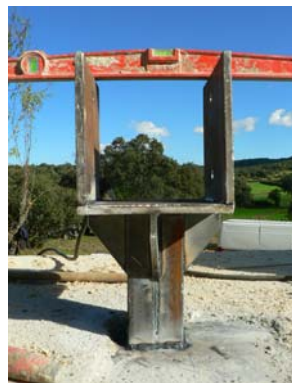
Pose nivelée d'appui
