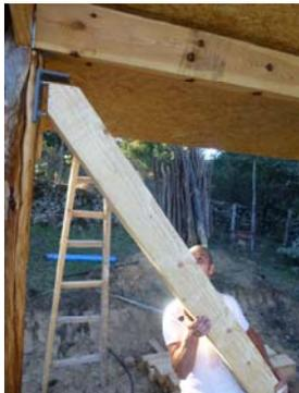
*Appuis des contreventements - Installation des contreventements transversaux et longitudinaux*
