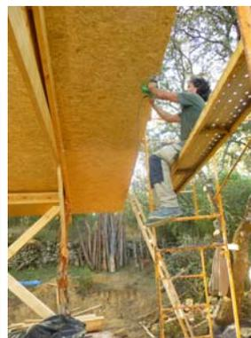
*Installation des plaques d'OSB et des pannes*
