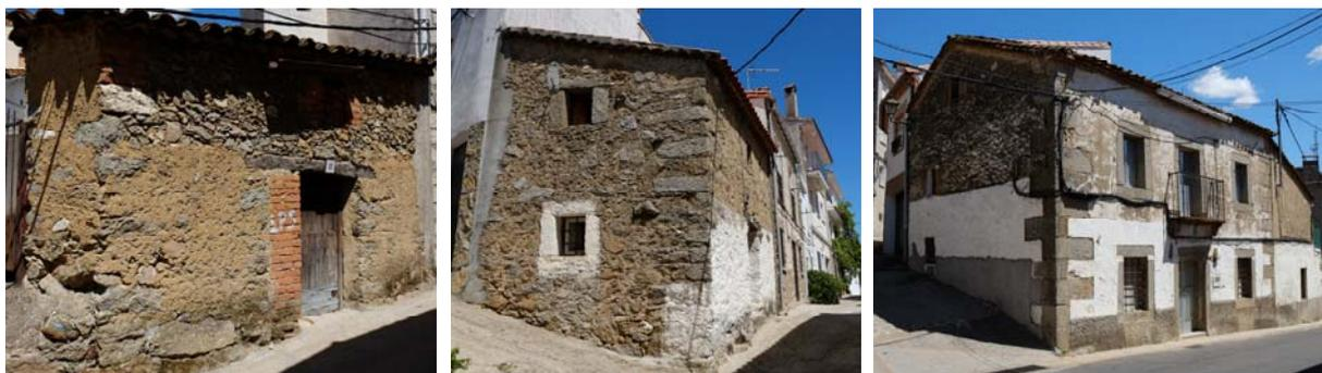
Les **portes et fenêtres** peuvent être encadrées par des grandes pierres taillées, mais les jambes peuvent aussi être remplacées par des maçonneries de briques cuites, et les linteaux par du bois : Dans ce cas, plusieurs poutres sont jointes pour couvrir la largeur du mur, et appuyées sur des traverses de bois noyées dans le mur. Par la suite, les portes et fenêtres n'avaient pas de vitres, mais elles se fermaient avec des volets en bois. Ils n'utilisaient pas de cadres encastrés dans les murs.
