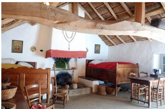
La structure en bois reposait directement sur le mur de terre, en dehors des fermes qui étaient soutenues par des piliers de bois placés à l'intérieur du mur en terre. Pour les tirants des fermes, on utilisait les troncs les plus incurvés comme si ils étaient des poutres précontraintes, ce qui contribuait à libérer l'espace intérieur. Pour la couverture, ils plaçaient des bouquets de roseaux depuis la partie la plus basse vers le sommet, en les attachant aux liteaux de la structure.
