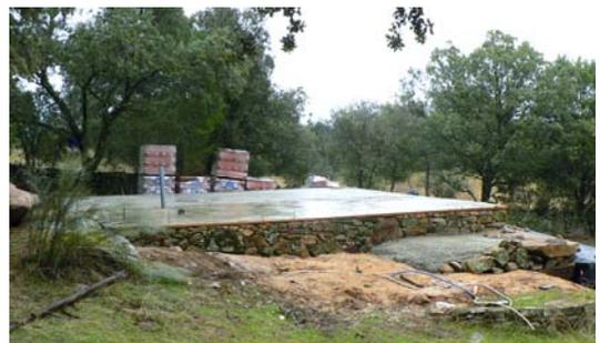
Sur cette base la maison est à l'abri des eaux capillaires. Ensuite, une structure en portiques s'appuie sur les semelles et tient de manière indépendante des murs, c'est-à-dire que les murs ne supportent pas de charges verticales, ils n'ont pour seul rôle d'isoler l'habitation des intempéries, et donc ils peuvent être construits avec un matériau léger à forte capacité d'isolation comme la paille. La paille sera détachée de la dalle par des lisses basses.
