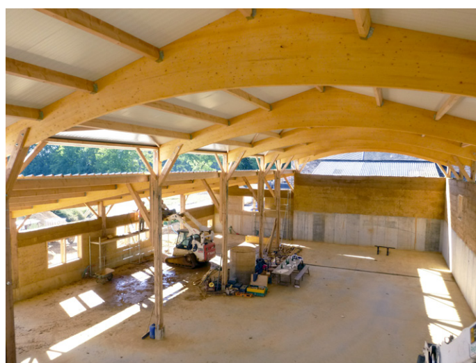
Images ci-dessus : Différentes étapes de la construction de la cave. Auteur 01 et 03 : Frédérique Jonnard Auteur 02 : Elena Camarasaltas Pérez
