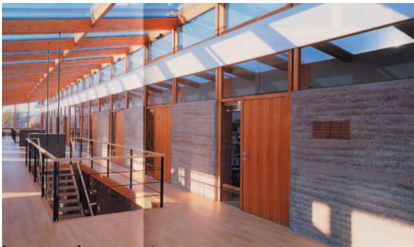
▲ 16 - Vue intérieur du bâtiment et des sorties d'air à travers les murs en pisé.
