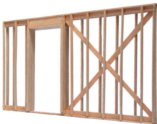
▲ 53 - Plan schématique de l'ossature 1
