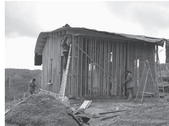
Installation du coffrage perdu
