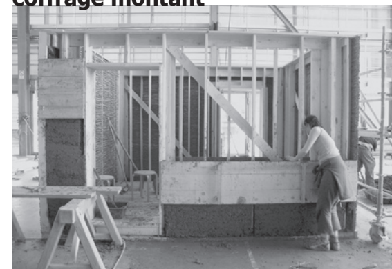
◀ 71 - Le remplissage en vrac par coffrage perdu
