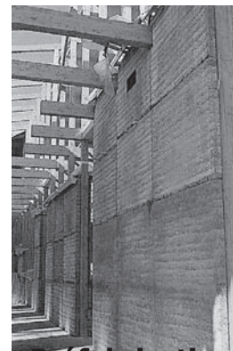
▲ 22 - assemblage et pose de blocs de pisé sur le lieu du chantier.
