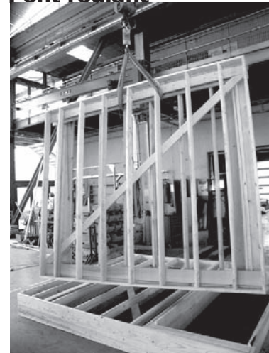
▶ 63 - Montage du prototype à l'aide du pont roulant
