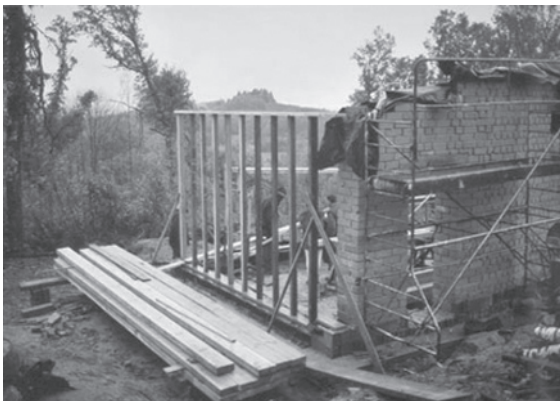
Montage de l'ossature primaire
