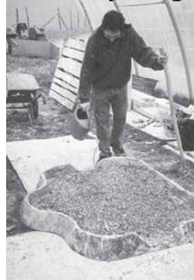
◀ 34 - Préparation manuelle du mélange terre et plaquettes bois. - Nov. 2003 -
