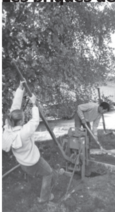
► 29 - Préparation et mise en œuvre des briques de terre compressée non stabilisée.
