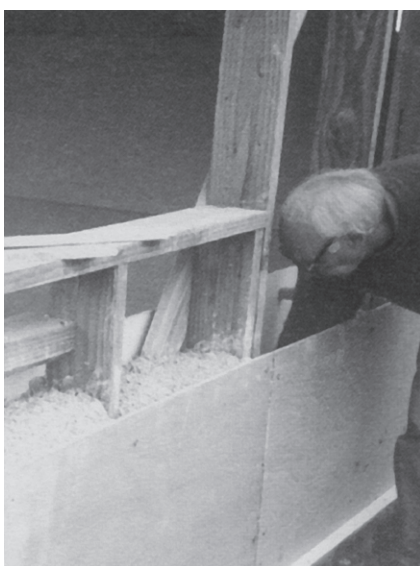
◀ 40 - Remplissage en béton de chanvre d'une ossature standard
