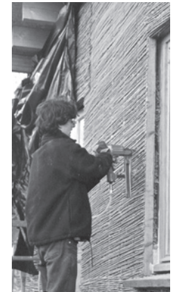
Installation du coffrage perdu
